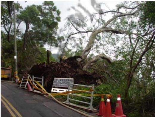
相片 15. 陽投公路沿線發生榕樹倒塌，造成路基受損現象。
