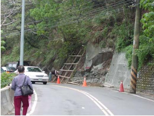
相片 17. 陽投公路鄰近停敘高工沿線，坡體有岩塊鬆動而崩落的現象。
