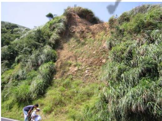
相片 7. 陽投公路沿線坡體受到雨水的沖刷，產生崩落的現象。
