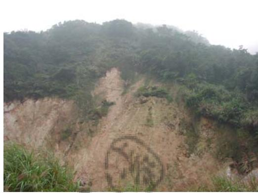
相片 18. 馬槽附近溪流集水區，發生坡體崩坍，崩坍長度約 100 公尺，寬約 50 公尺。
