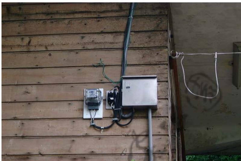
圖九 一個 GPS 觀測站所使用之電力來源裝置。
