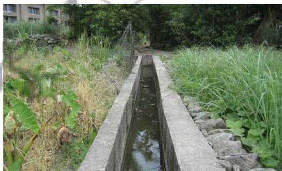
2.取水自標高 300 公尺之八煙溪起點稱頂圳明渠約 350 公尺，在軍事用地內阻塞水路的 200 公尺。
