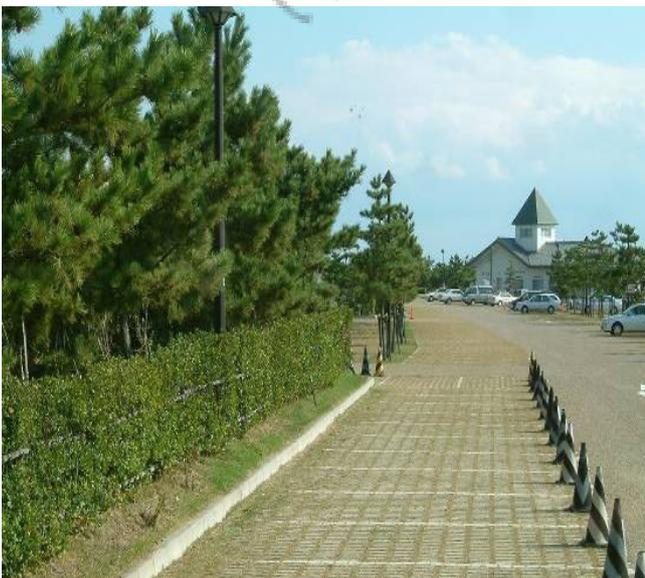
圖8-50 停車空間鋪面材質應具透水性
