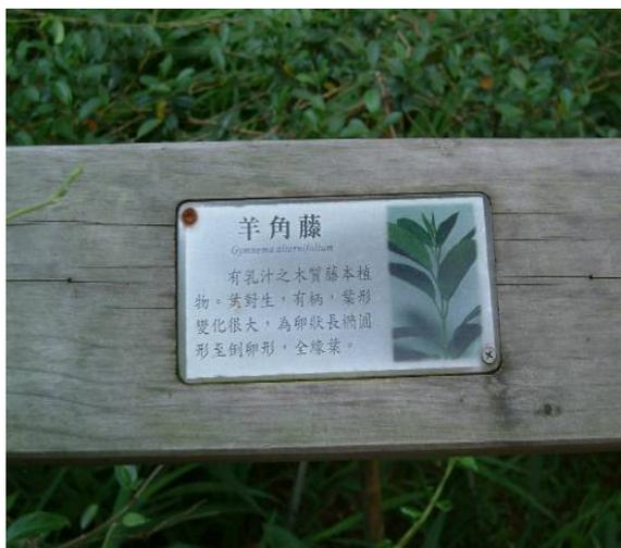
圖8-70 小型植栽解說牌可沿步道結合扶手設計
