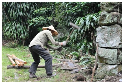
第三步：將擊裂的塊石，逐漸敲製到需要的大小
