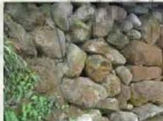
打洞、擊破、碎裂、拾起、堆疊，這是打石砌屋前先要做的動作。將整塊石頭打破，不太大，不過小，有力的雙手時起剛剛好。
