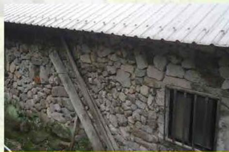
背風面石牆由大小石塊及泥沙堆疊、填補而成。
