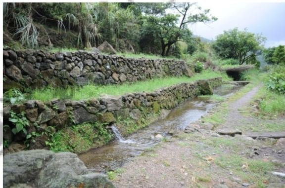
採用傳統砌石工法建造的水圳
