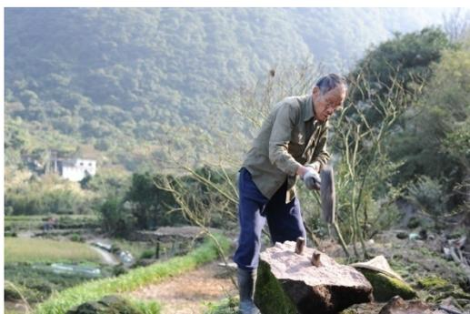
第二步：將鑿進大石塊中的鋼釘(至少 3 根)以擊石鎚敲進大塊石中，製造裂痕
