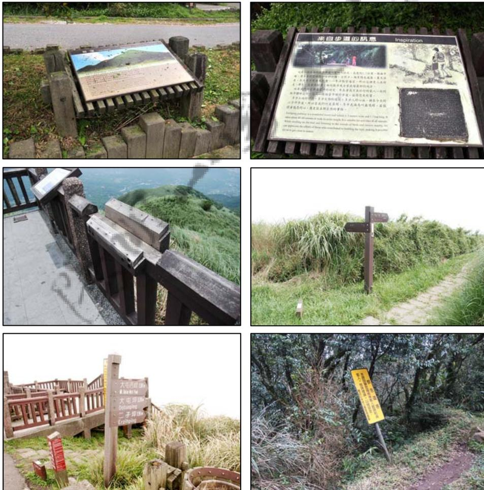
■ 部分解說牌誌有汙損、版面遺失、傾倒的狀況，應即刻予以修復
