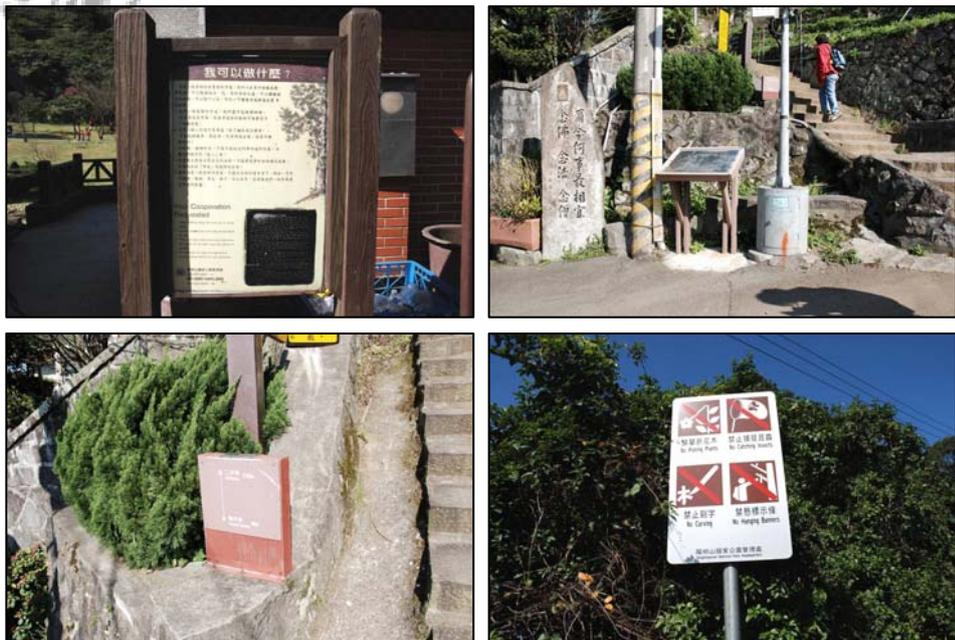
■目前基座主要使用木材、鐵、鋁板、鍍鋅鋼管等材料。鐵製基座易因陽明山區硫磺氣體影響而鏽蝕損壞。 嚴淑銘攝
