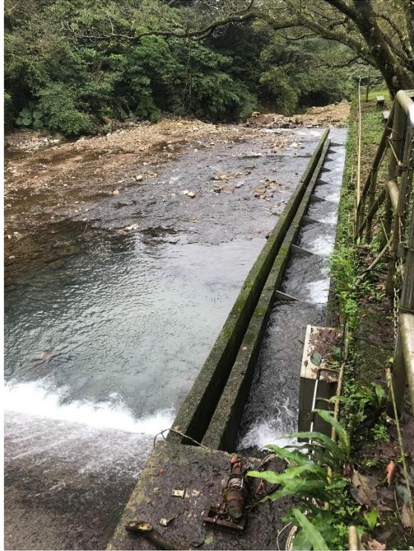
照片 三-6 魚梯改修更換成不銹鋼檔板後整體通水的情形(2018/11/31)
