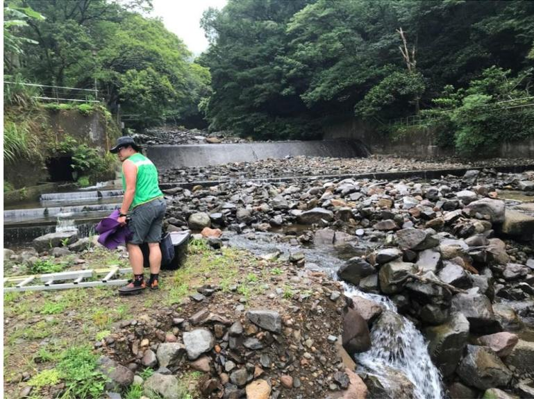
照片 三-20 取水堰下游河床落差加劇的情形(2019/07/02)
