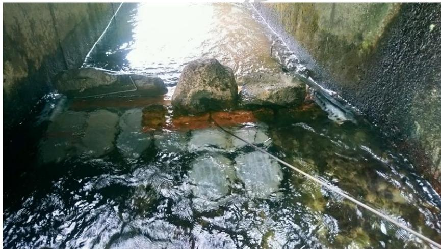
照片 三-26 水池隔壁式魚梯出口設置陷阱
