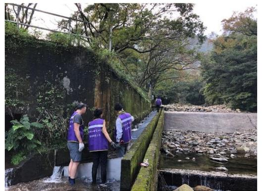
照片 三-5 魚梯改修更換為不鏽鋼隔板的情形(2018/11/31)
