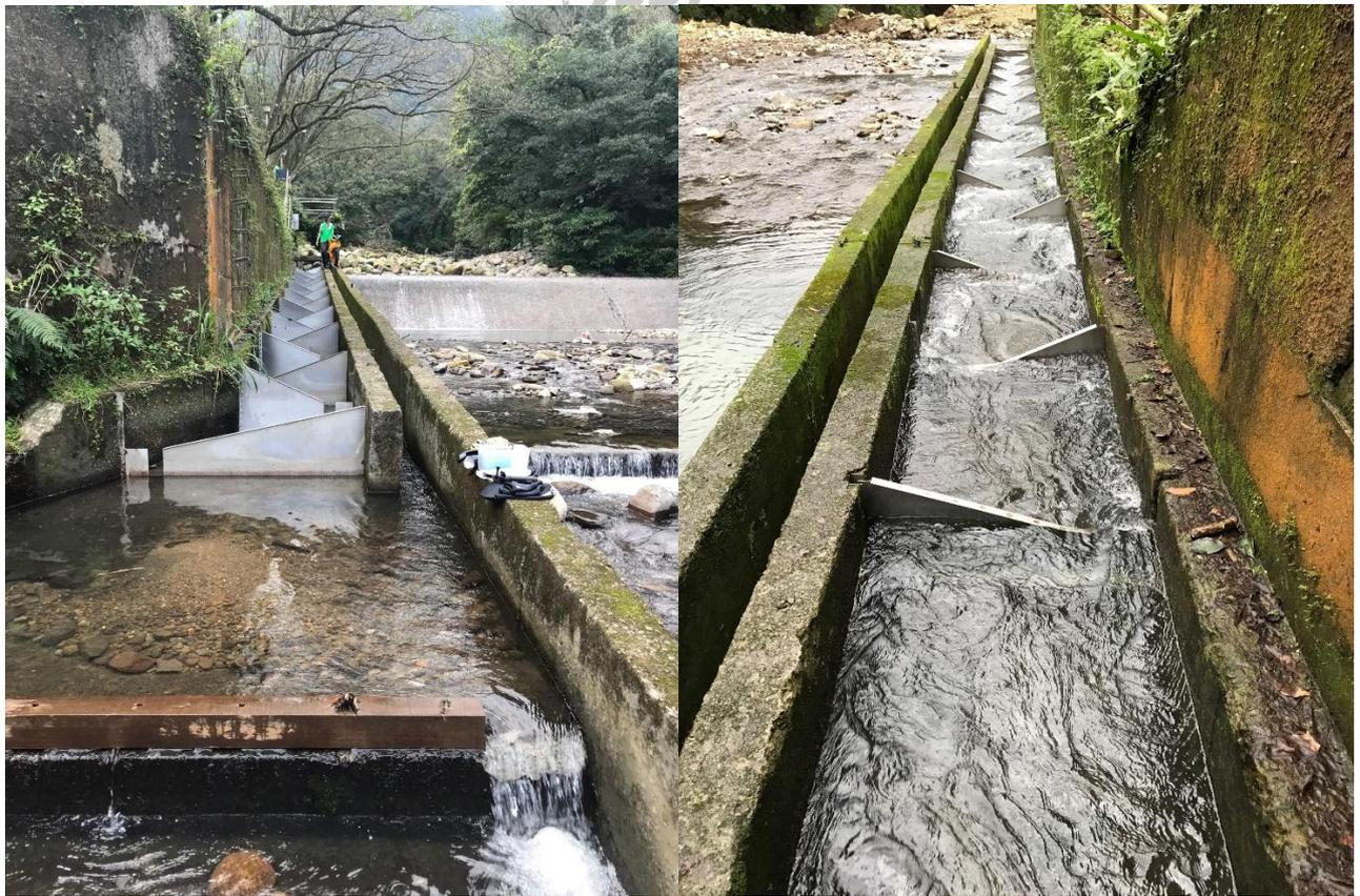
照片 三-7 魚梯加設隔壁後的情形(2019/01/31)
