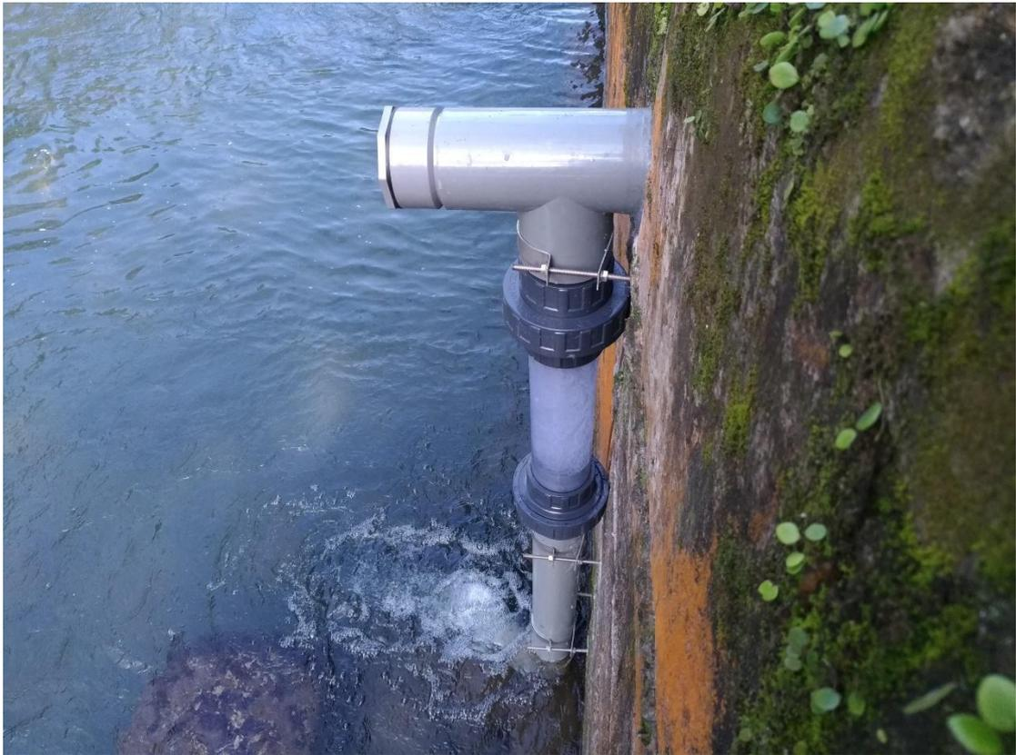
照片 三-22 管狀魚道裝設直後進行通水測試(2019/03/12)
