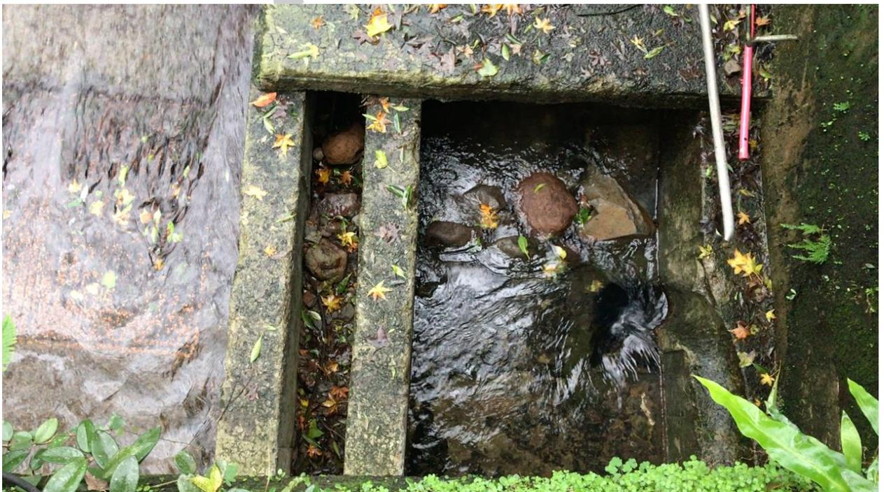
照片 一-1 鹿角坑溪取水堰附設魚梯底部破損情形(2015/03/09)
