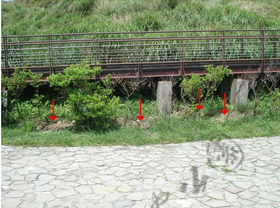
圖三十六 電纜線沿步道埋設（箭頭處），深度約 20 公分。
