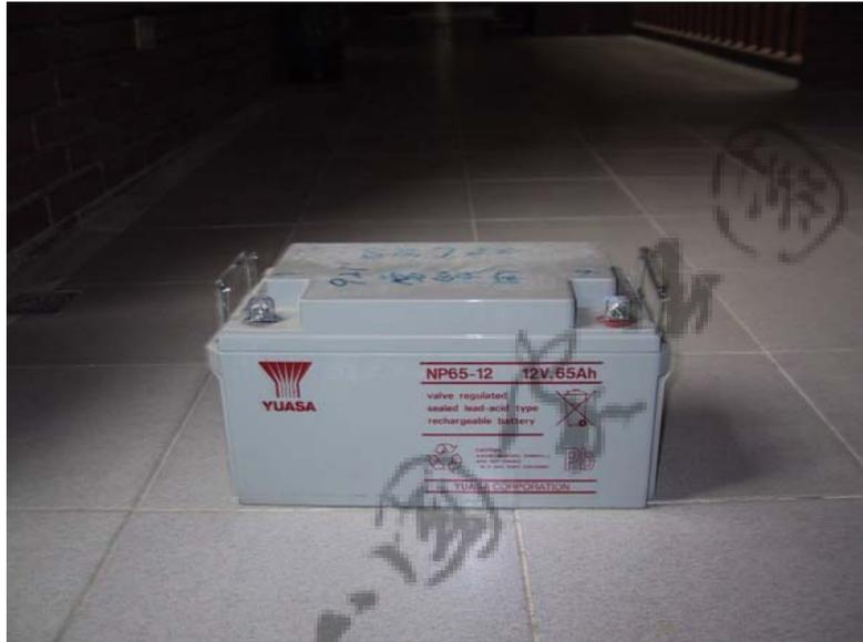
圖十六 一般微震站內維持地震儀器運作之主要電池
