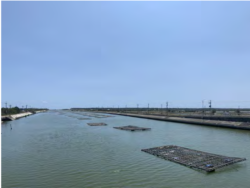
圖 2-07：河道寬廣的鹿耳門溪（2020 楊家祈攝）
