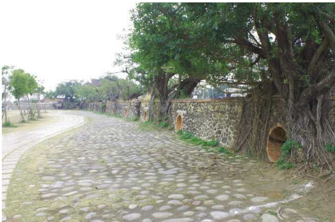
圖 3-18：四草砲臺牆垣東側
