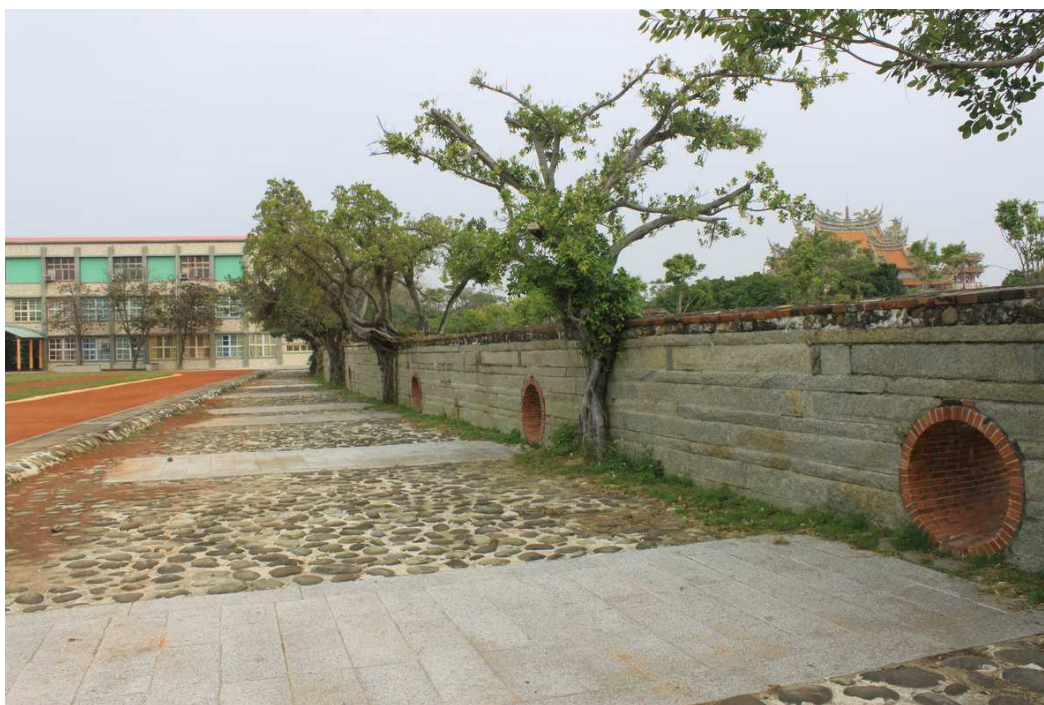
圖 6：四草砲臺牆垣西側
