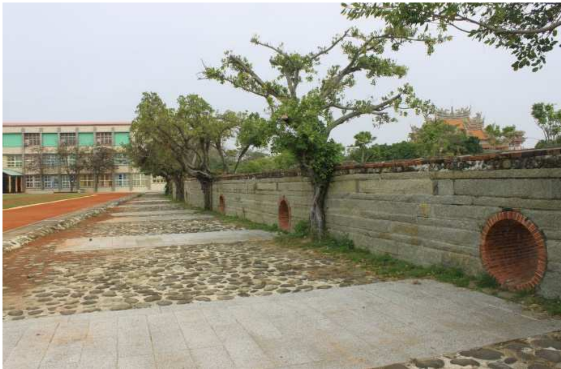
圖 3-17：四草砲臺牆垣西側
