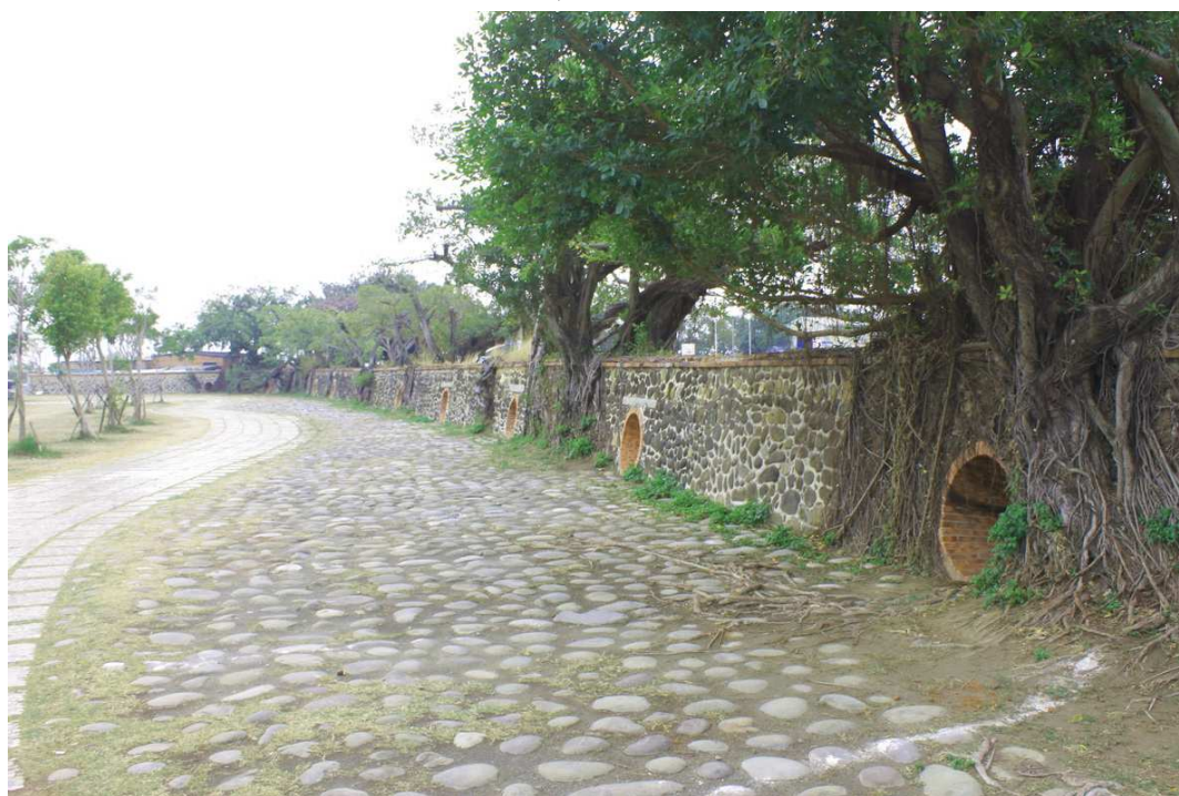
圖 7：四草砲臺牆垣東側
