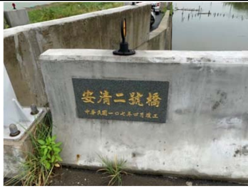
竹筏港溪安清二號橋
