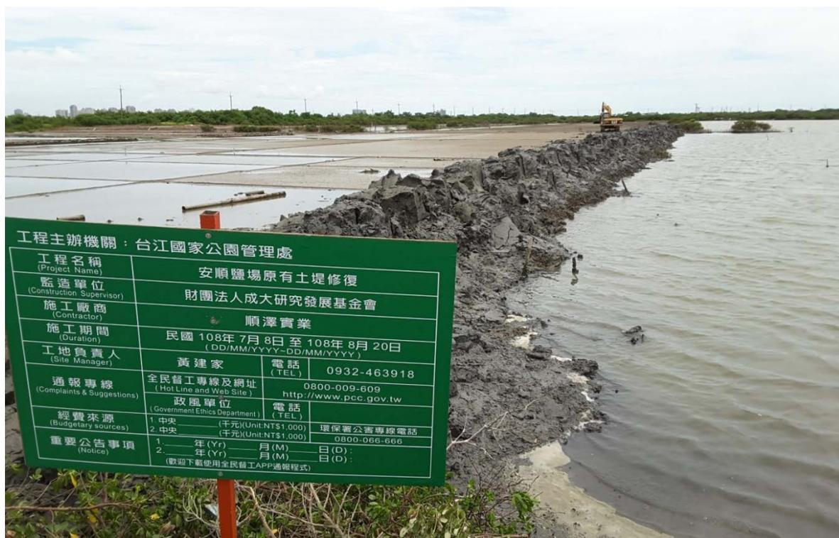
圖 5.7 原有土堤修復培厚工程告示及工作概況
