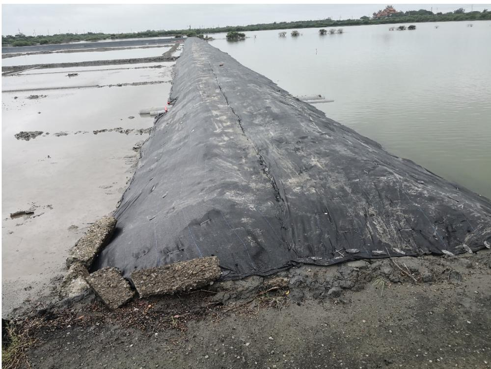
圖 5.16 土堤包覆黑色塑膠網及進水管完工照片
