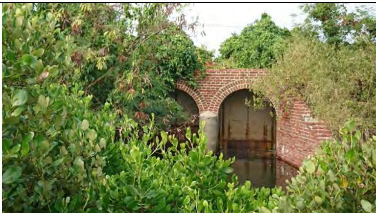
圖 3-4 計畫區北汕尾水道水門現況照片
