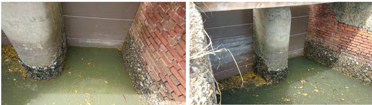
圖 4-2 水門修復後測試水密性
