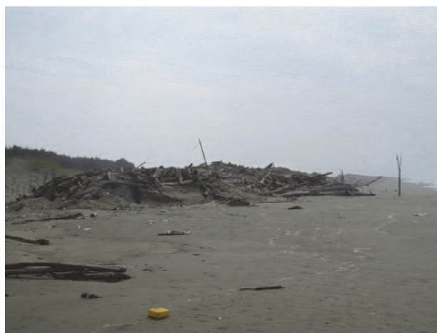
S1樣區人工沙丘施作後的情形
