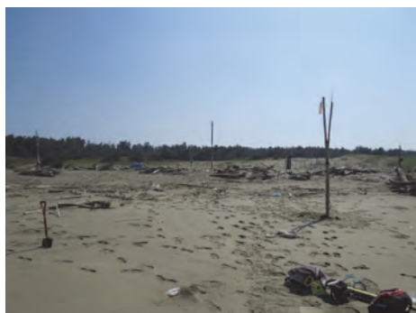
S1樣區人工沙丘施作前的情形
