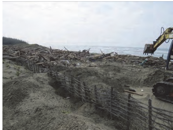
照片4-3-19 N樣區土方堆置(11/3)
