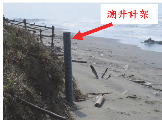
照片5-2-9 溯升計基樁更改地
