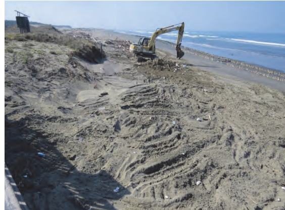
照片4-3-9 木平台南側清理(10/30)
