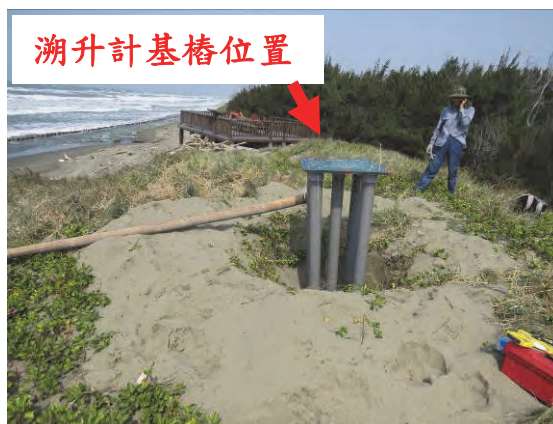
照片5-2-8 基樁及溯升計架
