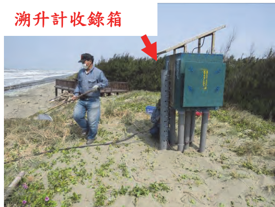
照片5-2-10 安裝潮升計收錄箱
