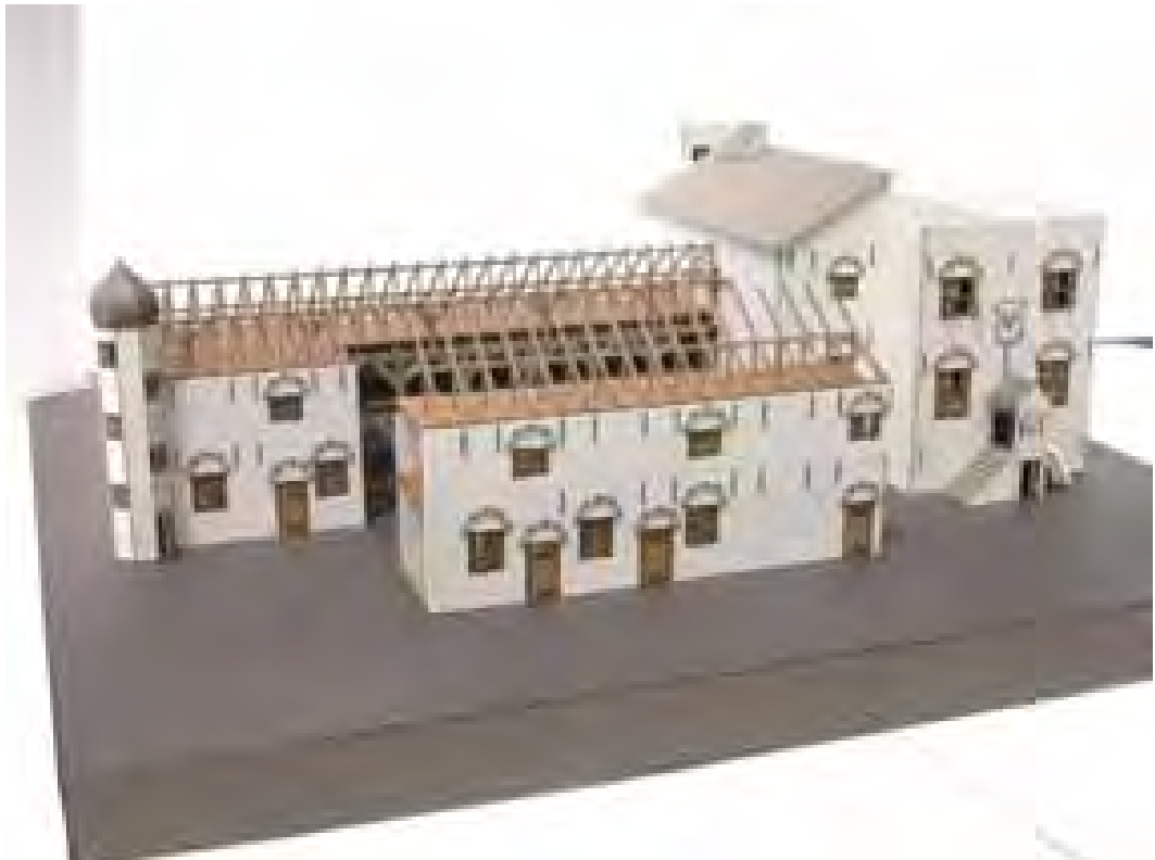
圖1-11：長官公署和倉庫模型連結內部樑架正面構造圖
