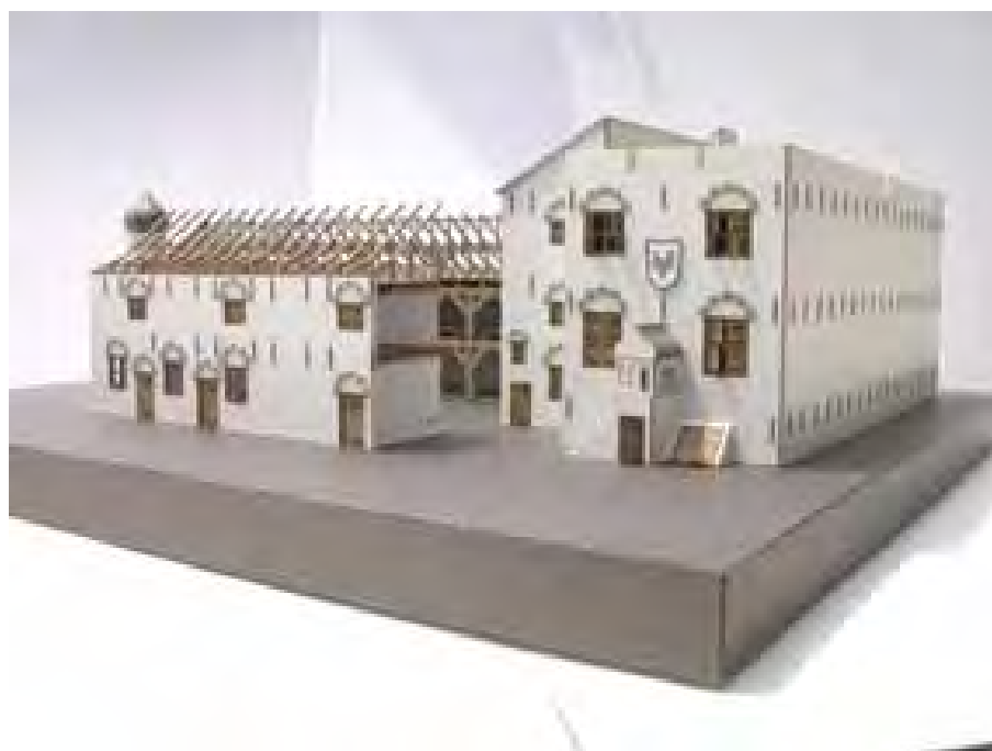
圖1-10：長官公署和倉庫模型連結內部樑架構造圖
