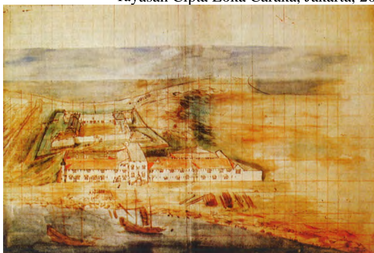
圖 2-13：1634-1635 年熱蘭遮城仍在建設中的長官公署和倉庫。
