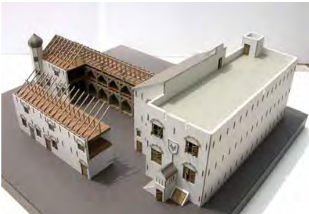
圖1-12：長官公署和倉庫模型連結內部樑架上視構造圖
