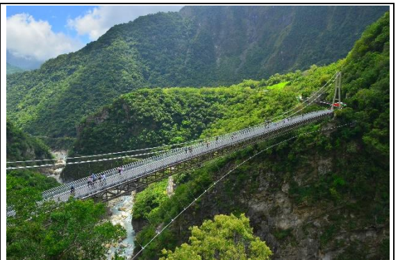
山月吊橋(空照圖)
