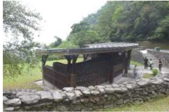
匯德遊憩區公廁
