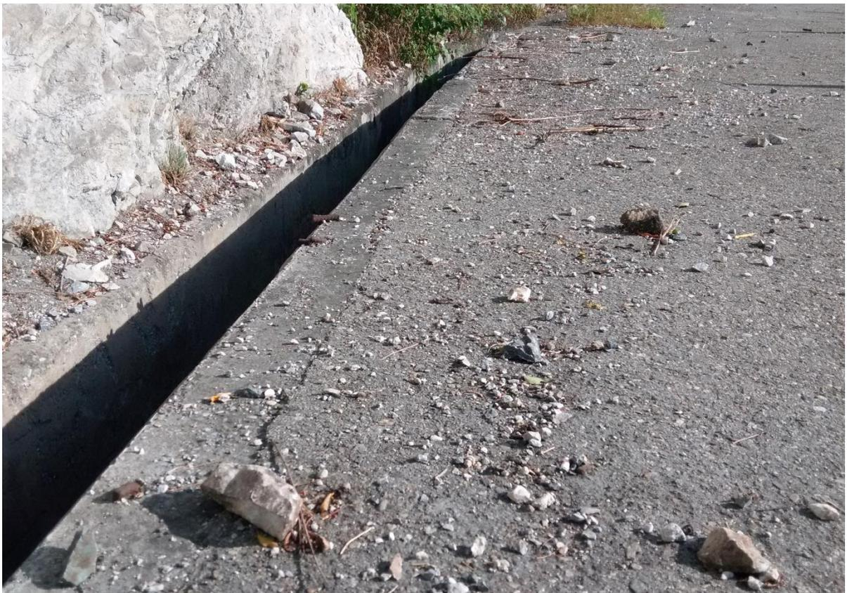
圖 4.6.1-4 崇德遊憩區北側裸地下方，於 103 年 8 月的調查中可觀察到許多落石崩落
