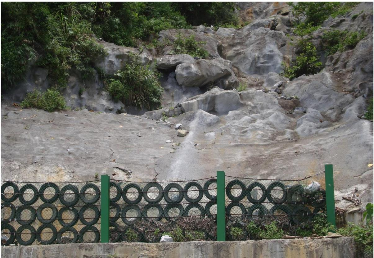
圖 4.6.1-7 蘇花公路 170.1 公里處，103 年 6 月以灌漿加固的坡地上仍可見到來源端所掉落的落石
