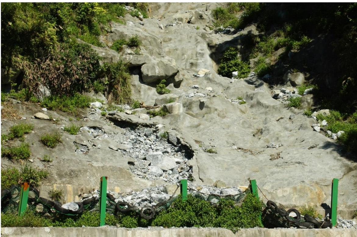
圖 4.6.1-8 蘇花公路 170.1 公里處，104 年 11 月以灌漿加固的邊坡遭到自然界的損壞
