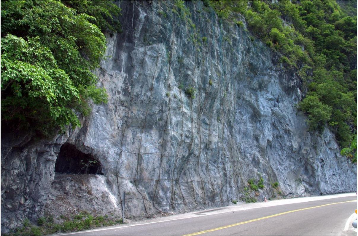
圖 4.6.1-5 崇德遊憩區北側裸露地層，於 104 年 6 月的調查中已有人工護坡
