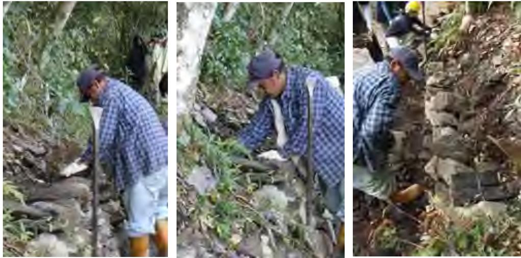
圖 3-2-3 乾砌石駁坎案例施作工序圖
