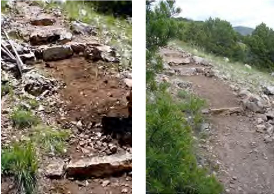
(4)、步道面整理，踏階石埋設及背填混合現地碎石、岩削、泥土充分夯實
