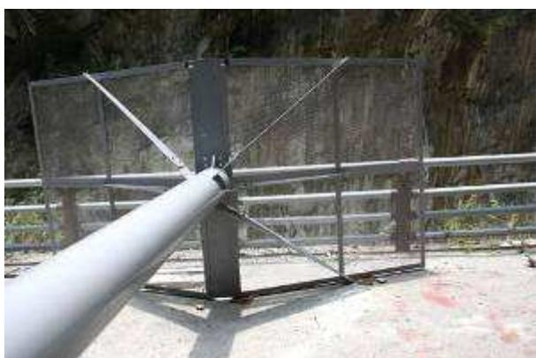
承柱為 10 吋 (25cm) 鋼管。鋼管長度 3.5 公尺，承接防護傘。
