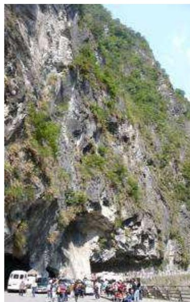
九曲洞西洞口落盤極度危險區欄杆範圍應包含整個落盤危險區。
