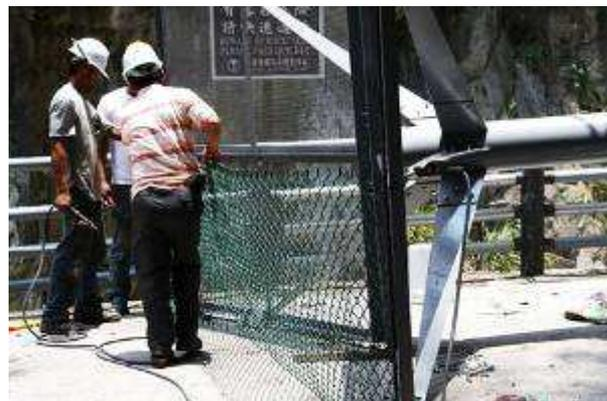
底層為 16 號 (10×10mm) 不銹鋼網；上層為 8 號 (50×50mm) PVC 菱形鋼網。
