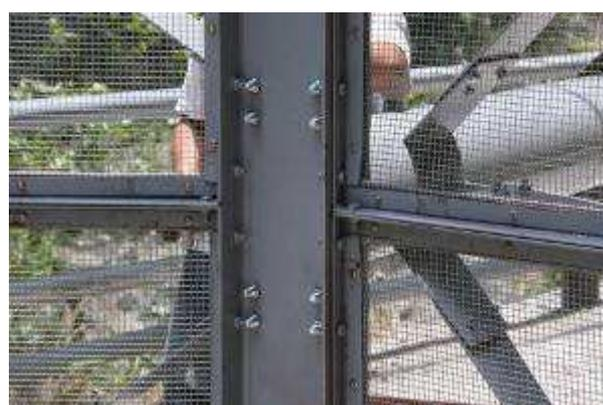
槽鋼栓在 10 吋鋼管頭部之鋼板上，完成防護傘與承柱之結合。
