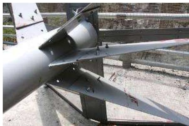
每面防護傘與焊在鋼管之三支 6mm 鋼板支撐架以螺釘結合。
