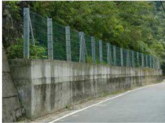
防落石柵欄之一類型，用以阻隔山側落石。在步道區可設計與環境相容之樣式與材質。
