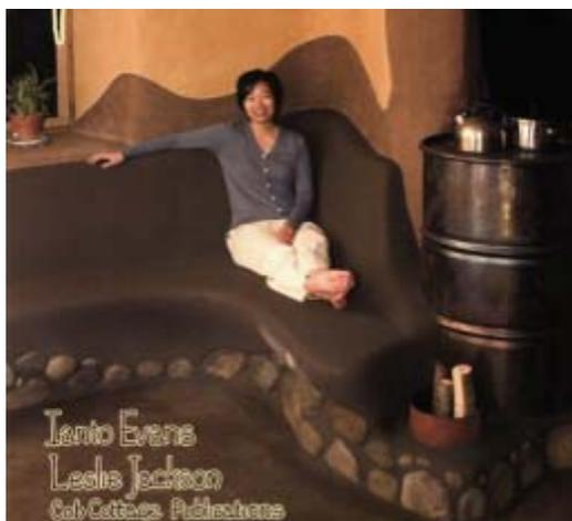
圖中右方的火箭柴爐可用來煮沸熱水，提供飲用，並有效燃燒木材不產生黑煙。其產生之熱能還能導入沙發座位，使人在上方或坐或臥都能感到十足的暖意，而整組沙發皆使用天然建材。
