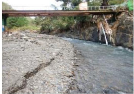
Y-29 斷面左岸為岩盤，右岸則有土砂堆積
