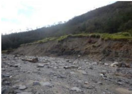
右岸土砂堆置處有滑落情形
