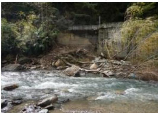
近護岸河岸崩塌，且護岸裂縫產生
