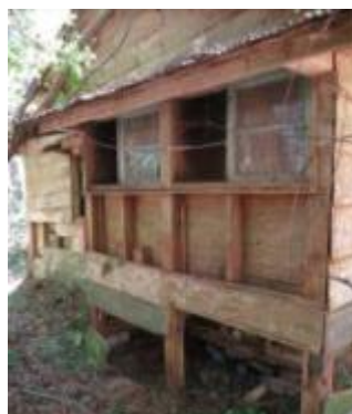
北坑駐在所重建工寮窗戶照
