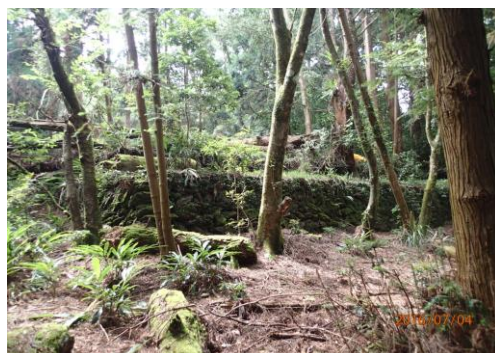
駐在所邊緣的堅固石牆
