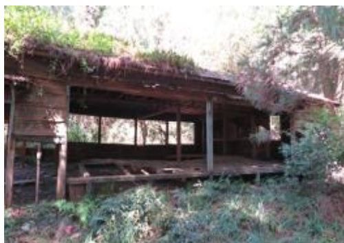
北坑駐在所重建工寮內部照
