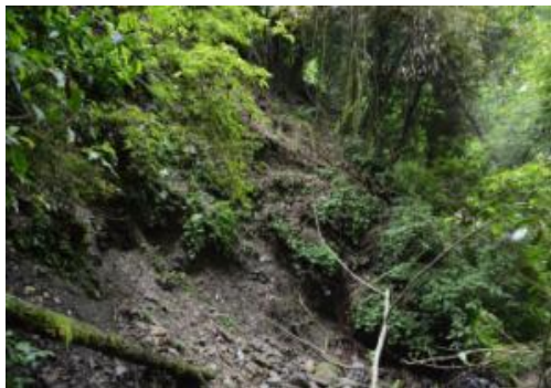
北坑駐在所水源旁崩塌
