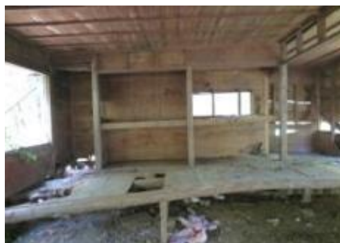
北坑駐在所內部重建工寮床板照
