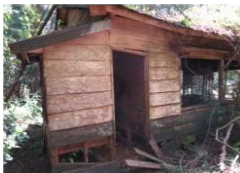
北坑駐在所重建工寮側面走廊照
