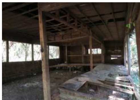
北坑駐在所重建工寮內部照
