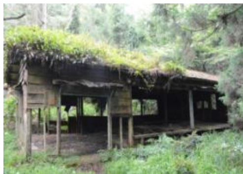
北坑駐在所重建工寮外觀照
