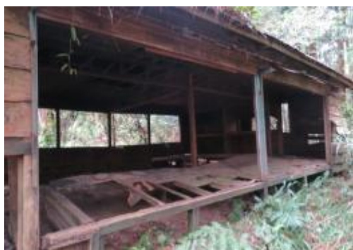
北坑駐在所重建工寮內部照
