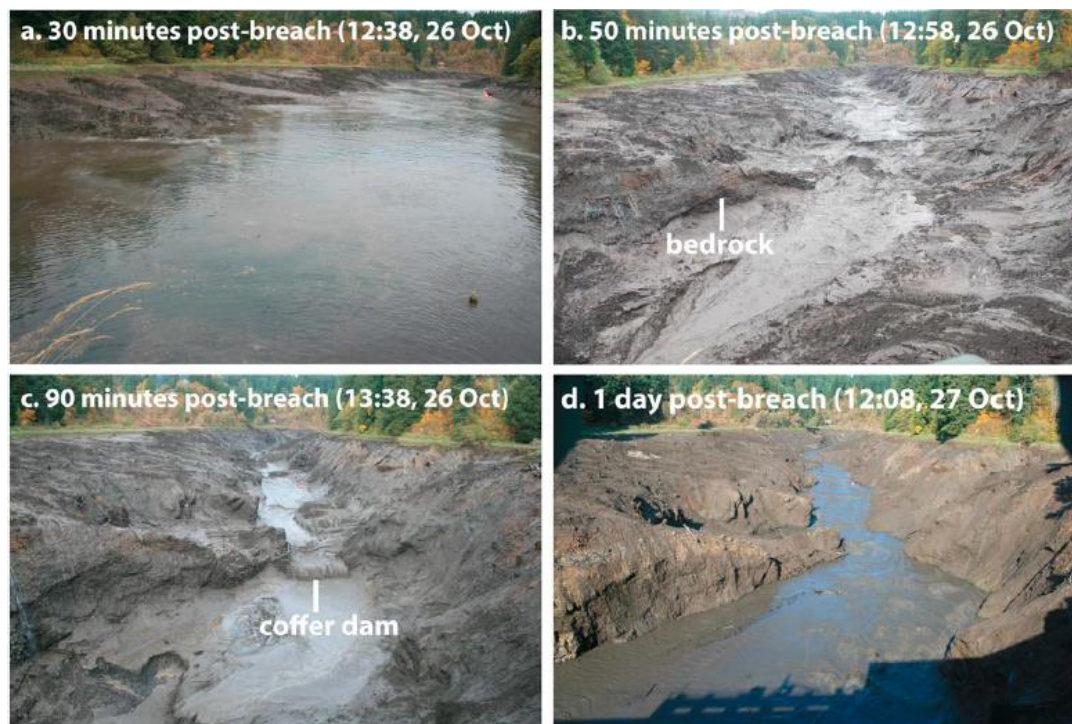
圖 2-8 潰壩後上游之時間序列圖 (從壩頂面向上游拍攝, Wilcox et al., 2013)
