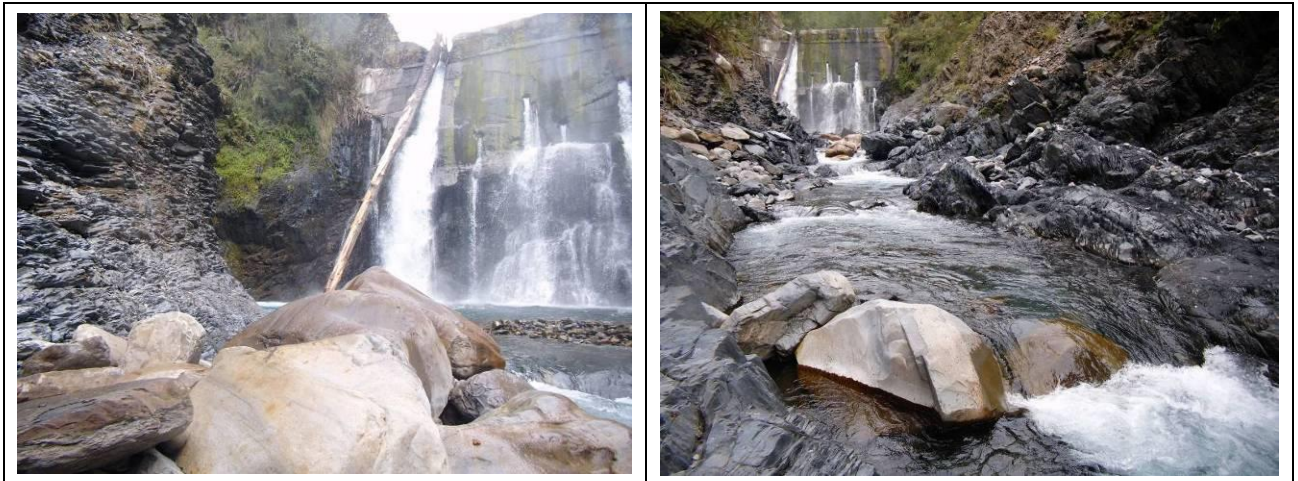
照片 2-15 三號壩右岸壩體損壞
