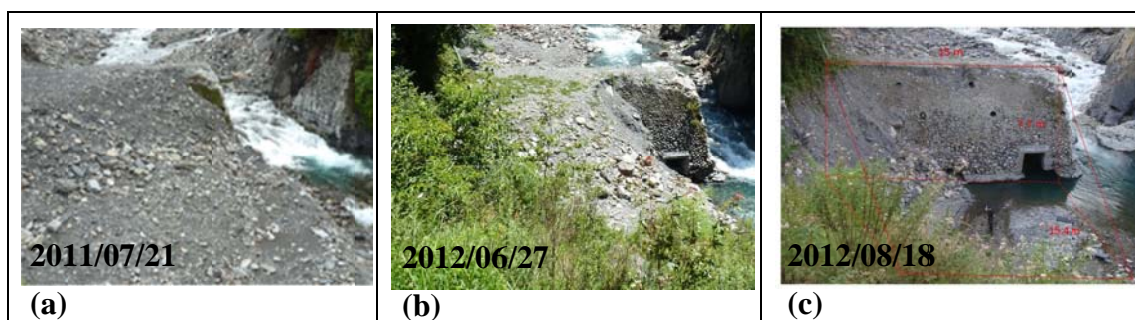
圖 4-1 回填土方變遷 (a) 米雷颱風後 (b) 梅雨、泰利颱風後 (c) 蘇拉颱風後
