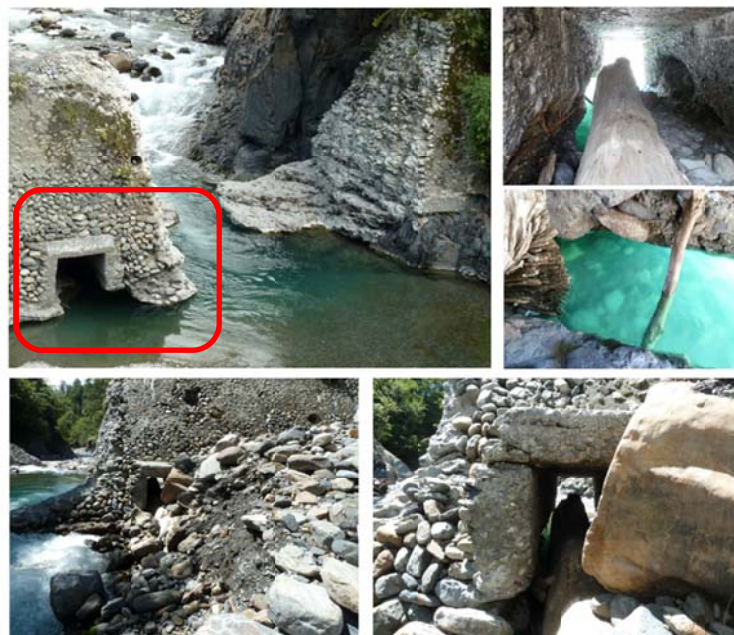
圖 4-12 一號壩殘存壩體壩基現況
