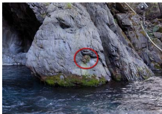
2011年3月22日拆壩前
