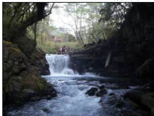
照片 3-13 断面 0-M 殘材壩(2012/02)
