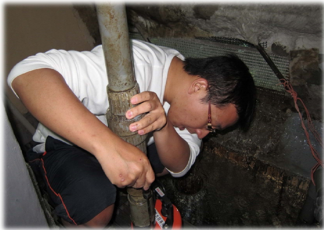
圖 8-34 抽水馬達故障更換
