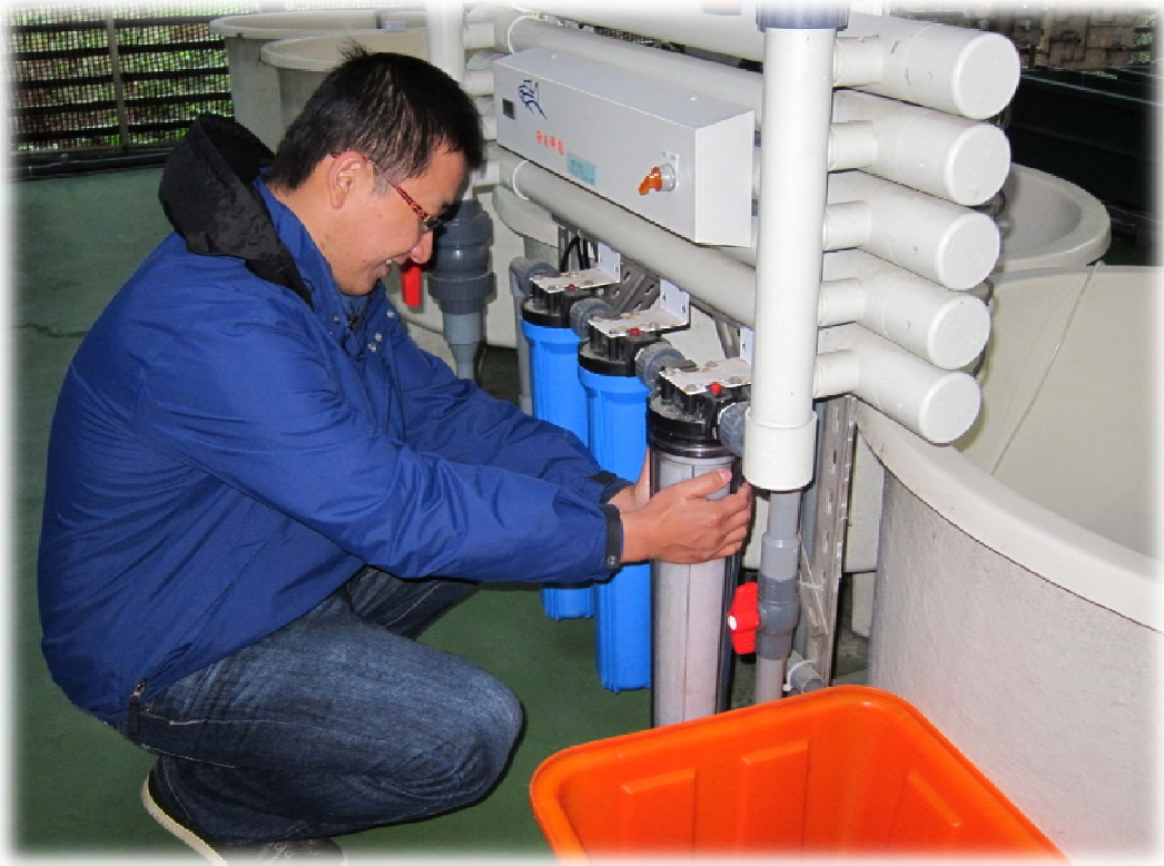
圖 8-29 馴餌池系統耗材更換
