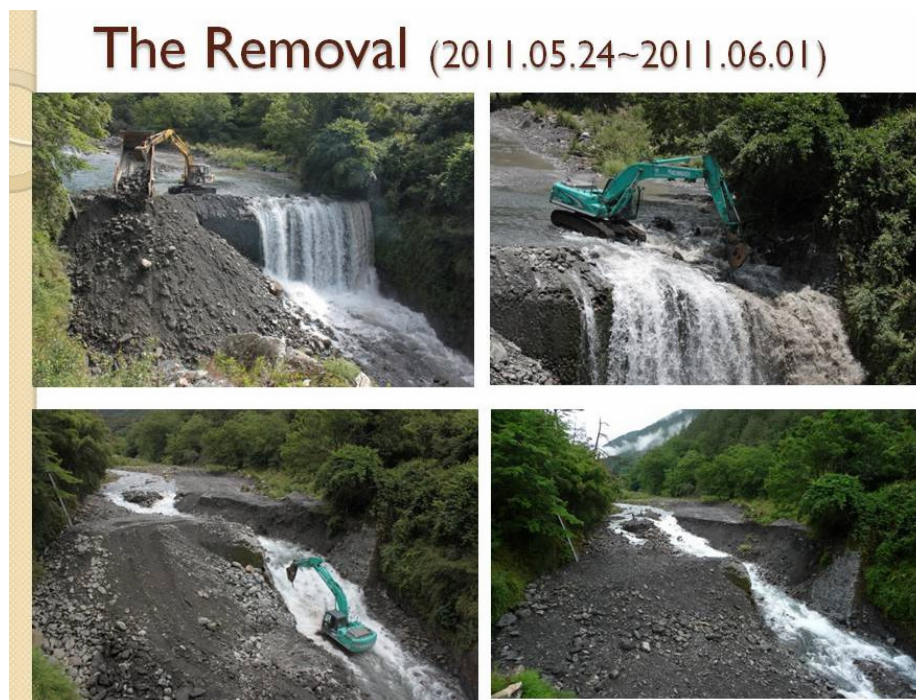
圖五、七家灣溪一號壩改善工程進行過程
