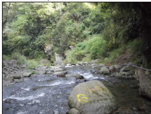
照片 3-10 斷面 1-E 下游面(2011/10)
