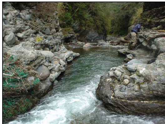
照片 3-13 一號壩壩口(2011/02)
