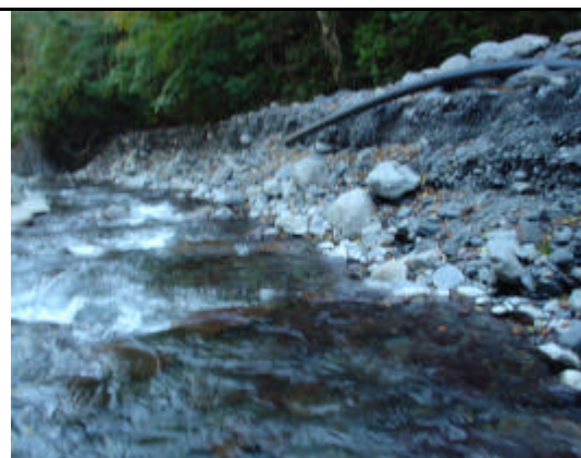
照片 2-18 斷面 2-23 邊坡狀況
