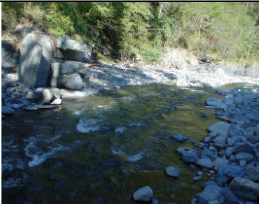
照片 3-13 二號副壩現況(2004-11)
