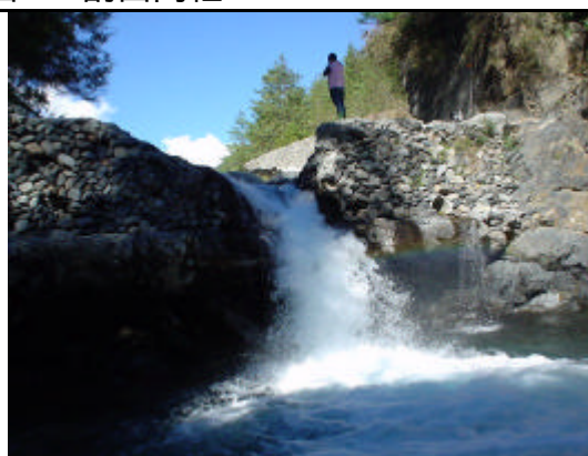
照片 3-8 二號壩現況(2004-11)
