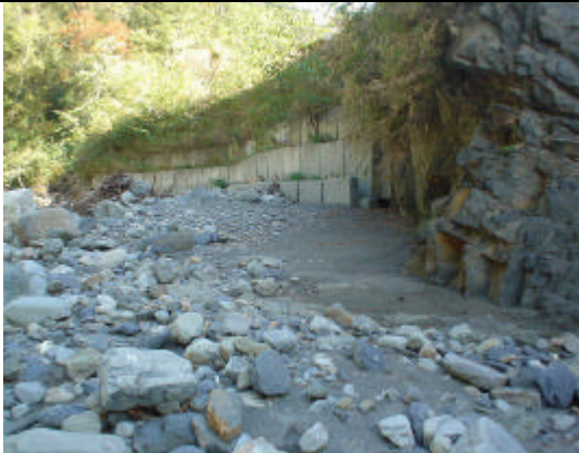
照片 3-17 斷面 0-A 右岸淤積
