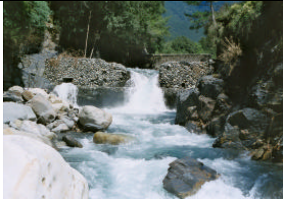
照片 6-10 二號壩壩址現況(颱風過後)
