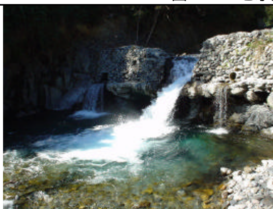
照片 3-7 二號壩現況(2004-11)
