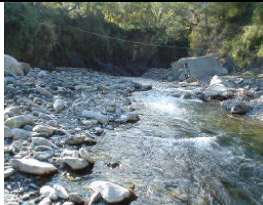
照片 3-12 二號副壩現況(2004-11)
