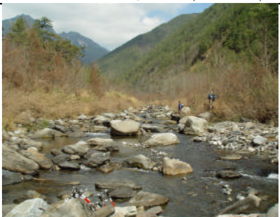
照片 6-5 二號壩上游直線段(今年二月)
