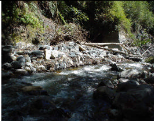
照片 2-5 四號壩上左岸坡面破壞
