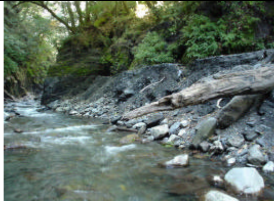
照片 2-15 斷面 3-4 邊坡土體狀況
