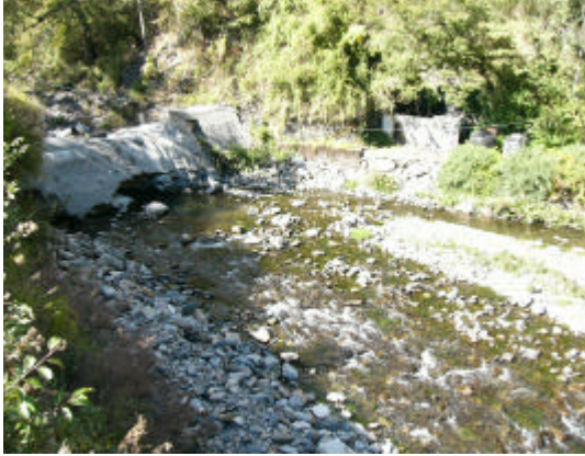
照片 3-15 二號副壩(2003-11)
