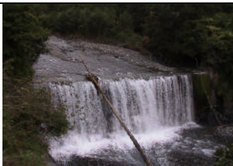
照片 6-24 七家灣溪一號壩現況
