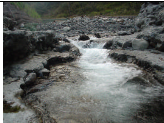
照片 2-32 一號壩現況
