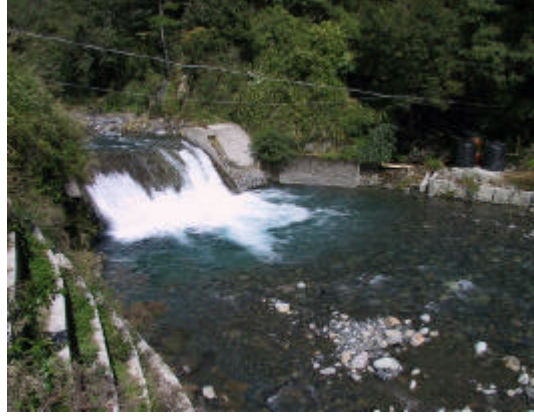
照片 3-16 二號副壩(2002-05)
