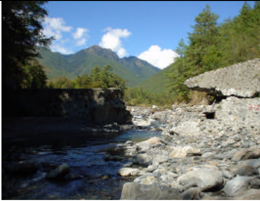
照片 3-5 斷面 3-1 舊二號壩
