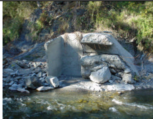
照片 3-14 二號副壩現況(2004-11)
