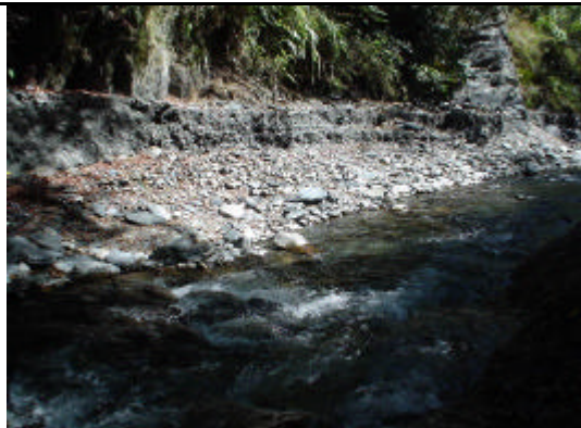
照片 2-11 斷面 3-19 邊坡土體狀況
