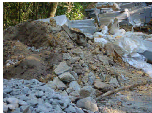
照片 5-12 現況照片
