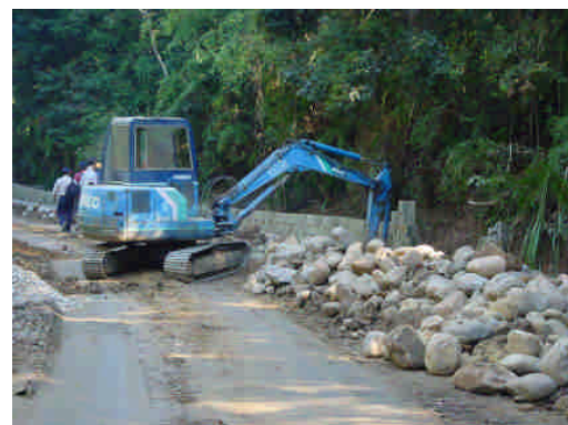
照片 5-14 現況照片
