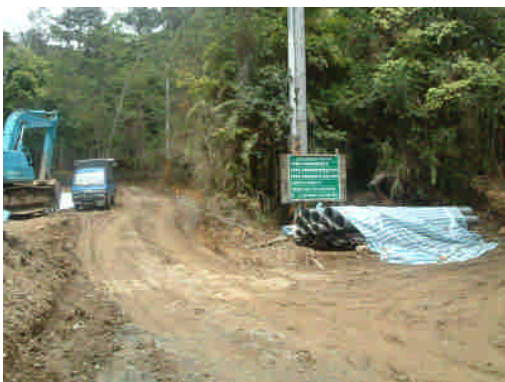
照片 4-15 施工前現況照片
