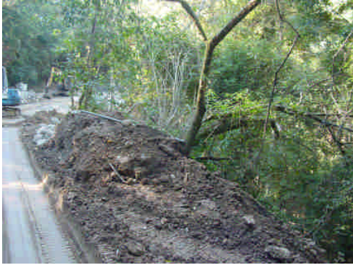
照片 5-7 現況照片
