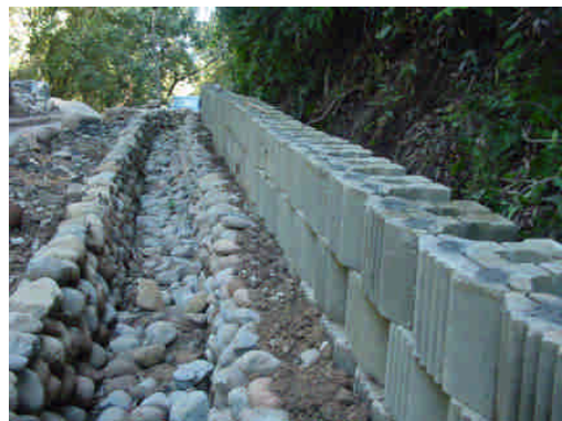
照片 4-22 工地現況照片
