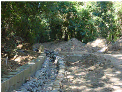
照片 4-21 工地現況照片
