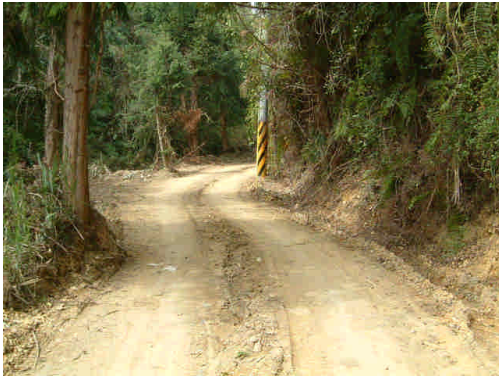
照片 3-3：遊客中心旁工程現況
