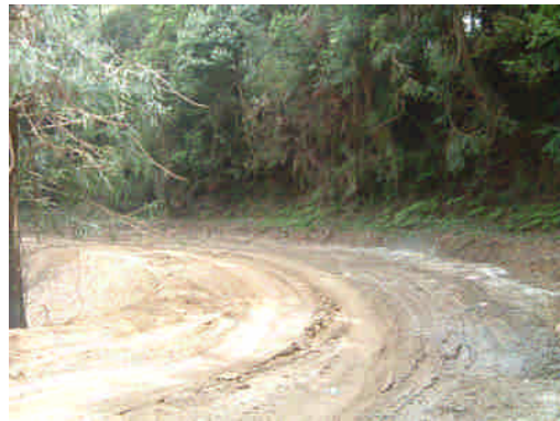
照片 4-14 施工前現況照片
