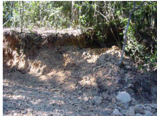
照片 5-6 現況照片
