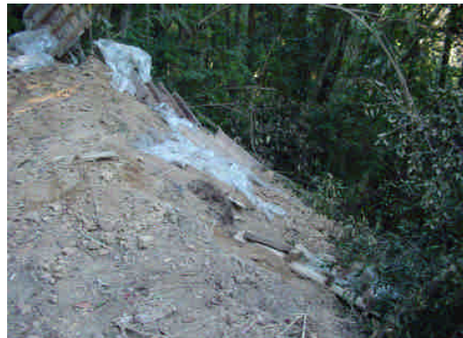
照片 5-10 現況照片
