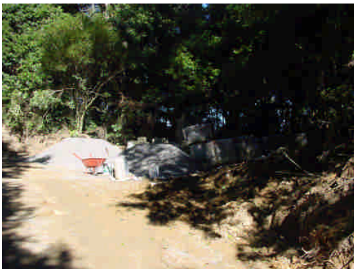
照片 5-13 現況照片
