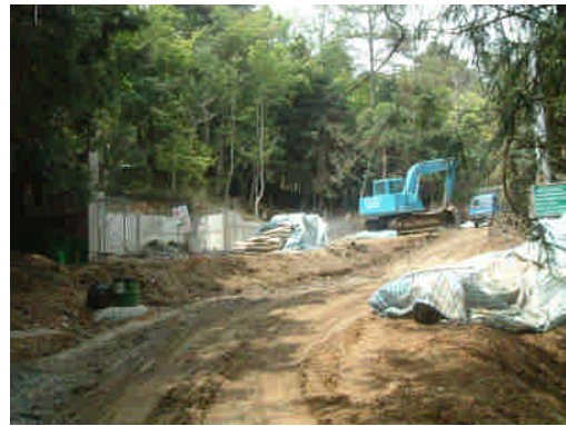
照片 3-2：遊客中心工程現況
