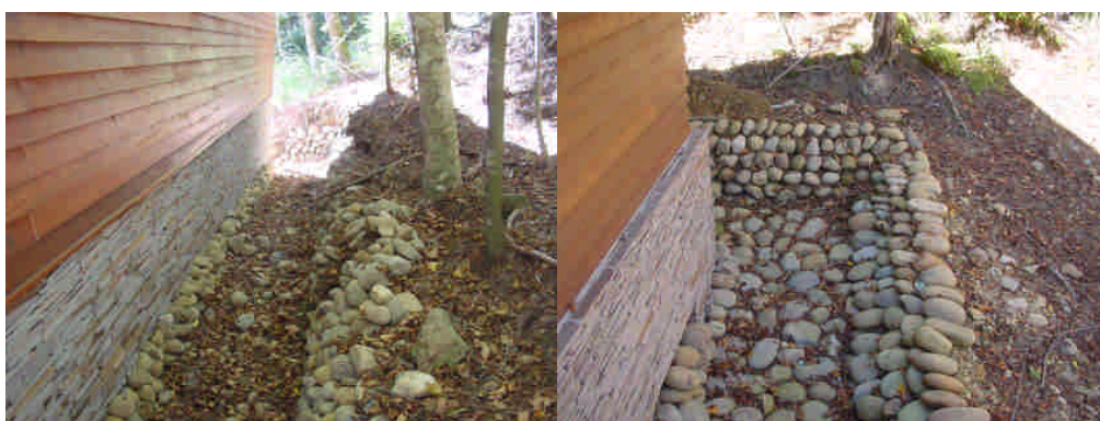
圖 6-6 邊坡表土之設計手法之案例
