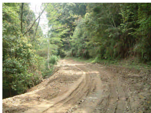
照片 4-16 施工前現況照片
