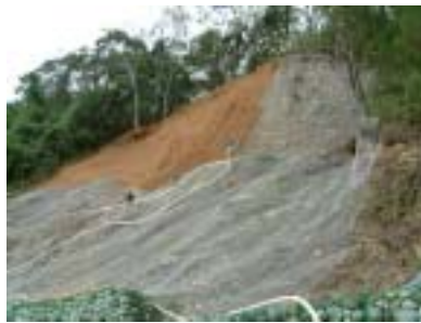
圖 5-3 錨釘鋪網之施工
