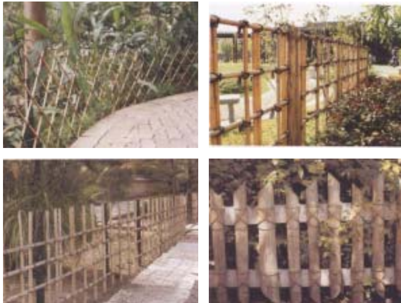
圖 5-28 運用當地材質(竹子)作為小路徑之景觀護欄
