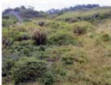
圖 5-1 邊坡植生工法
