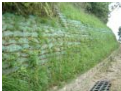
圖 5-5 施工後植生之情形
