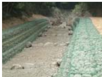
圖 5-15 上邊坡排水路
