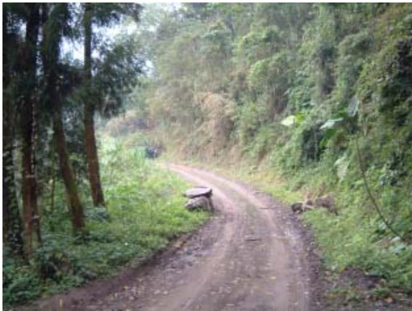
圖 2-5 司馬限林道未完成整修之路段
