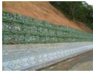
圖 5-4 基腳處設置石籠穩定坡面
