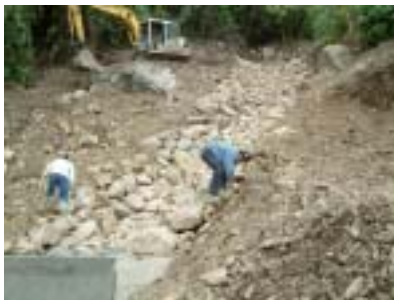
圖 5-18 塊石排水路施作過程
