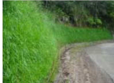
圖 5-2 邊坡植生工法
