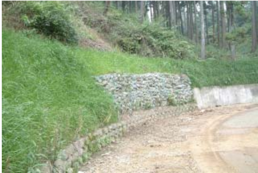
圖 5-7 道路邊坡穩定性不同，應用之工法亦不相同。
