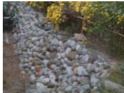
圖 5-9 塊石疊砌穩定邊坡
