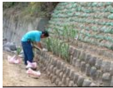
圖 5-6 基腳處以塊石疊砌穩地坡腳
