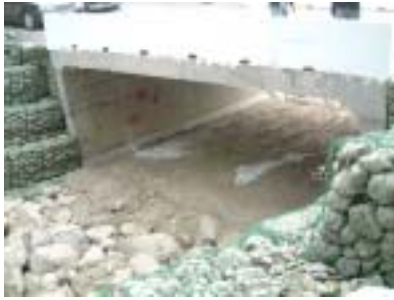
圖 5-16 道路下方之排水道
