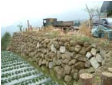
圖 5-8 塊石疊砌穩定邊坡
