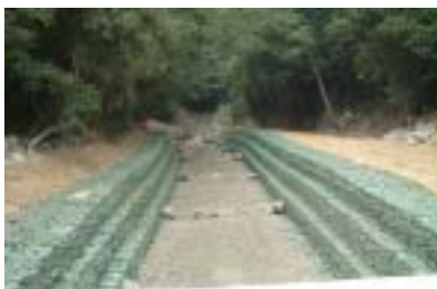
圖 5-14 上邊坡排水路
