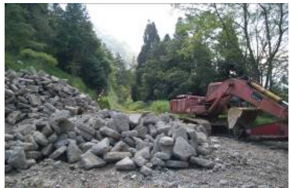
圖五 大鹿林道東線工程進行中
