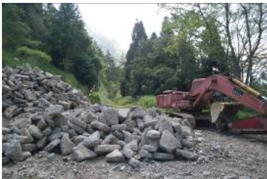
圖六、大鹿林道東線工程進行中
