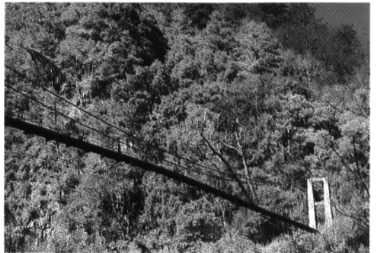
6. 大霸尖山登山口吊橋
