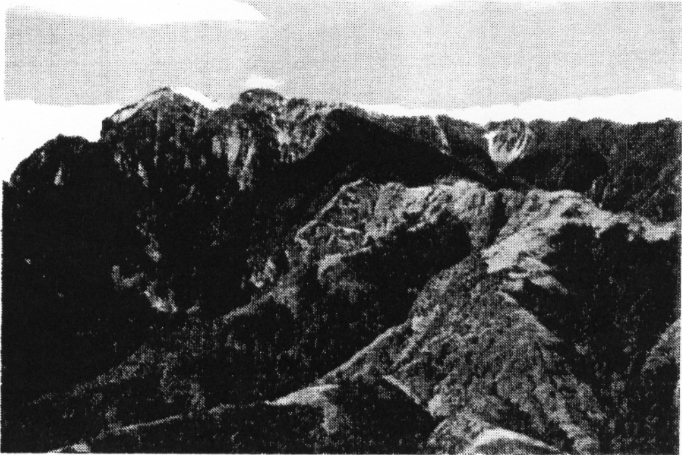
照片4B：V區雪山崖坡（Scarp），現狀崩坍地。（齊士暉 攝）
