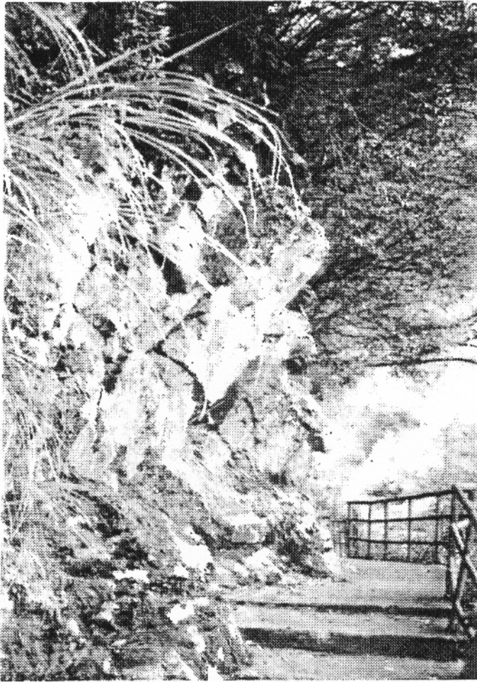
照片10B：三茅亭亞穩定岩石邊坡（變質砂岩）。
