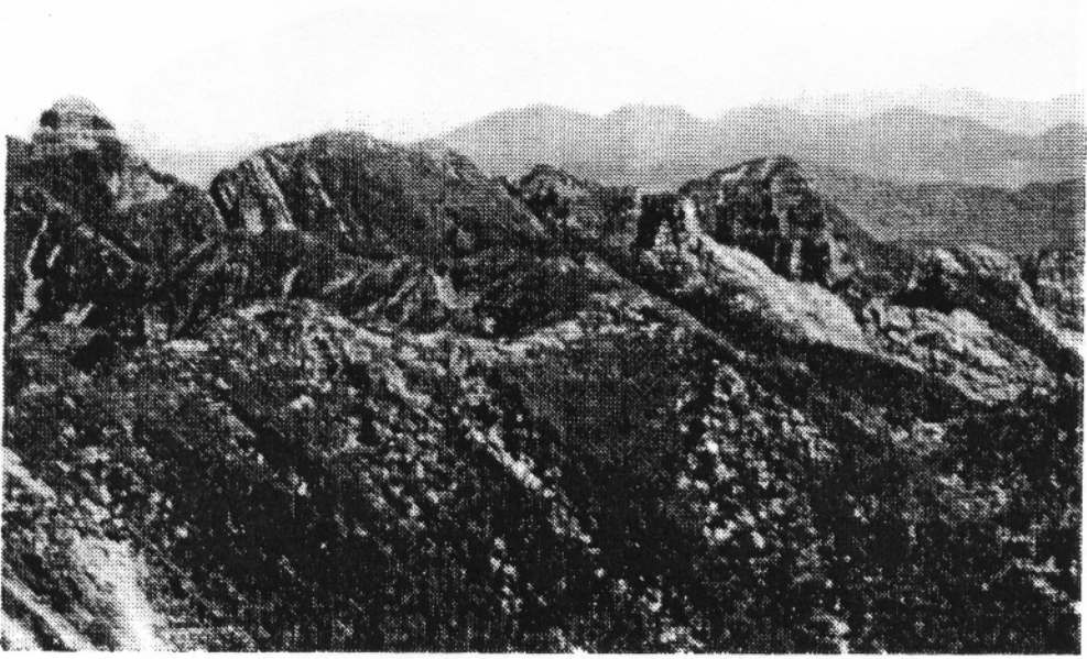
照片4A：III區聖稜線，現狀崩坍地。（齊士暉 攝）
