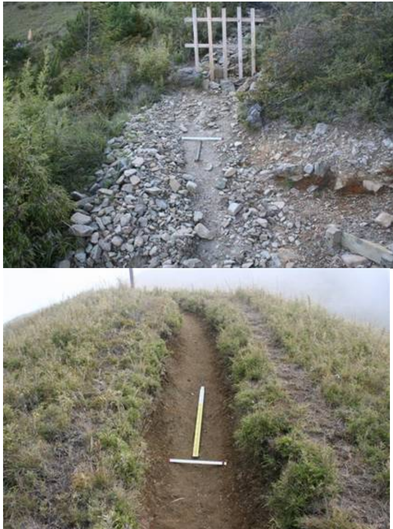
圖 17 雪東線步道侵蝕現況(4K~7.1K)
