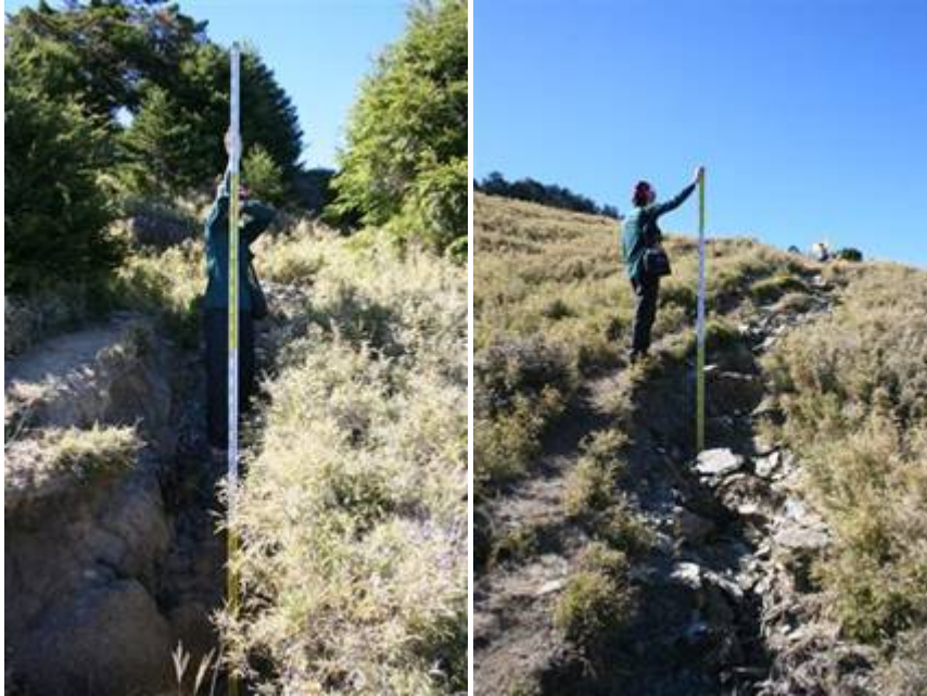
圖 23 新達山屋後方草坡侵蝕現況
