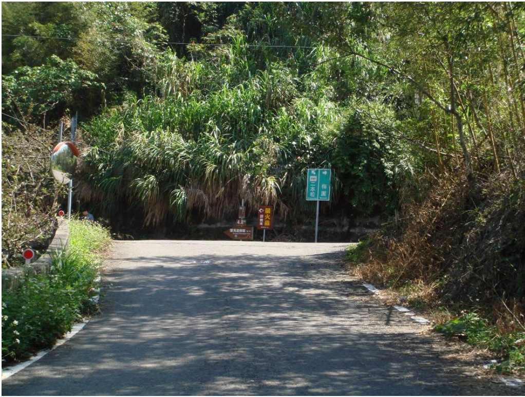
圖 5-47 苗 61/中象路口改善前現況
