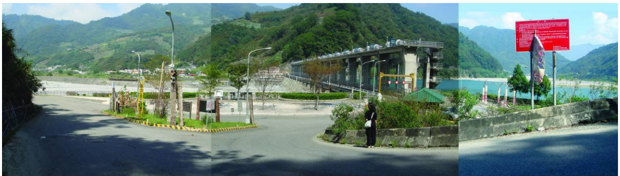
圖 5-24 士林大壩旁分隔島現況
