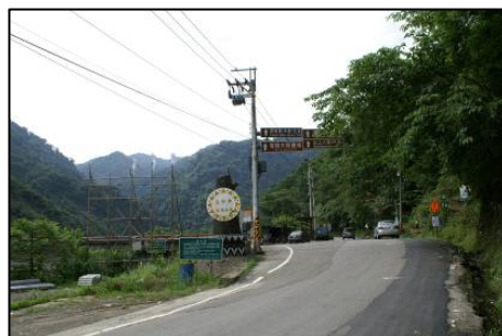
■ 現況五峰大橋前之五峰鄉入口意象及周邊環境
