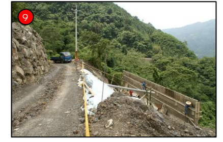
9 往和平之道路坍塌，現僅利用單線道路通行，旁邊已施工修建
