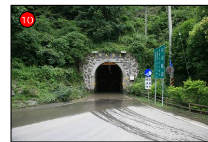
10 桃山隧道一次僅供單向車輛通行，但內有會車灣可會車
