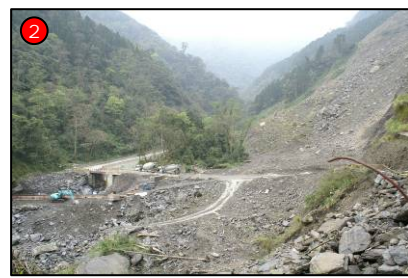
2 大鹿林道 8-9K 處山坡崩塌，面積非常大，具危險性
