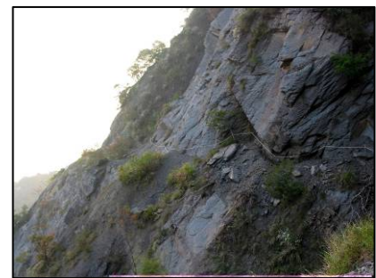
■ 北坑溪古道沿途較陡峭之地區，常因連日降雨造成崩坍，不易通行，其中尤以荖岡大斷崖最具代表特色
