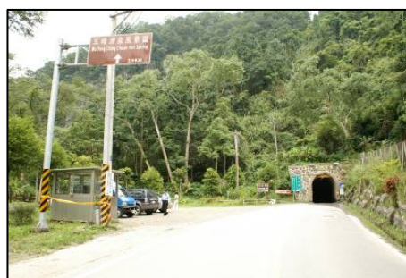
■ 現況桃山隧道北側入口及周邊環境
