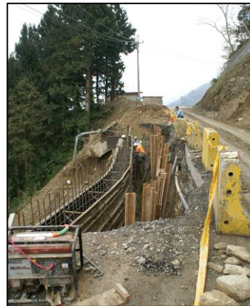
■ 道路坍方搶修施工狀況
