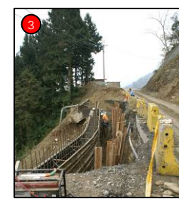
3 大鹿林道約 14K 處道路崩塌，上邊坡的擋土牆工程已大致完成，目前正在整修下邊坡部分
