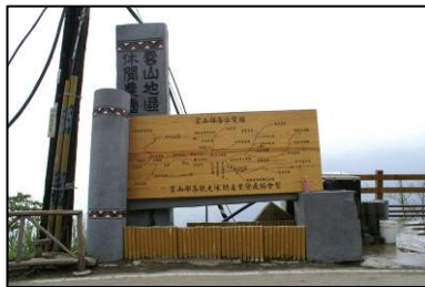
■ 立於雲山部落入口之水泥基座、木製版面導覽牌誌
