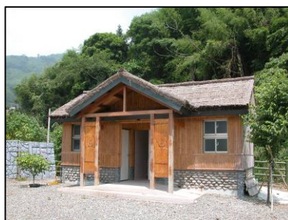
■ 停車場之公共廁所在建築結構外以雕刻門版、竹子牆面及茅草屋頂，包覆出傳統住屋
