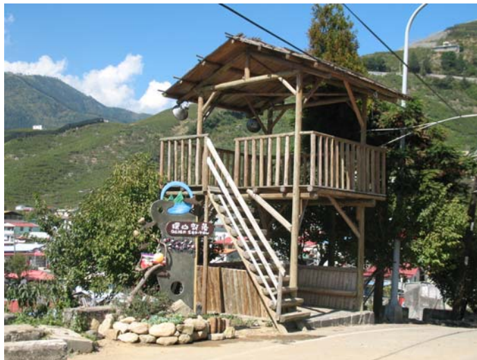
圖 3-1-8 環山部落入口意象施工完成圖-2 (本案工作小組拍攝)
