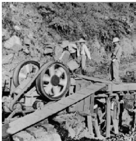
照2-3-5 碎石機打出碎石，墊鋪路面 照片來源：東勢林區管理處提供
