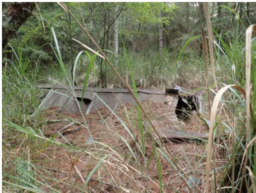
圖 3. 雪霸國家公園志佳陽大山山區舊的工寮。
