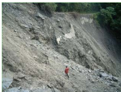
圖 5-32 上下邊坡崩坍
