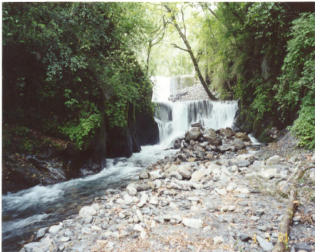
照片二、高山溪二號防砂壩改善前及改善後（90.10）
