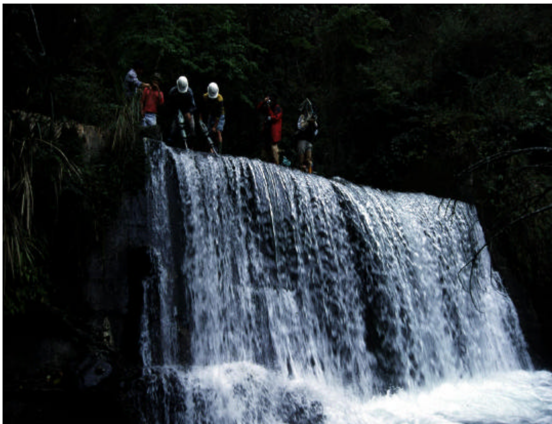
照片四、高山溪四號防砂壩改善前及改善後（90.10）
