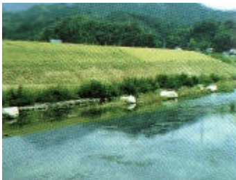
施工後一年。相當程度的恢復。
