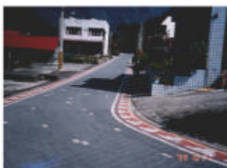
利用透水性連鎖磚作道路鋪面。
