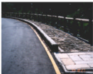
原木護欄及石塊鋪面使人車分道安全性更高，並增加環保特色。
