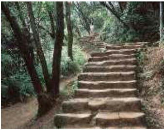
虎山步道砂岩石階取自當地的沙岩地質
