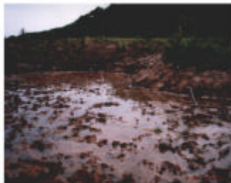
冷水坑湖泊 - 施工中
