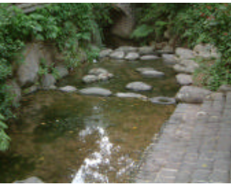
天然塊石作表面處理
