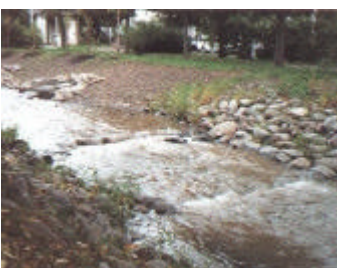
多段斜路式落差工
