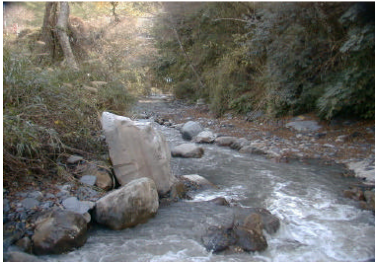
照片 5-25 斷面 1-8 河道轉彎處狀況
