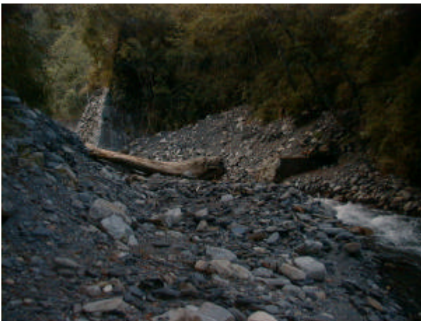
照片 3-16 一號壩拆除後壩口狀況
