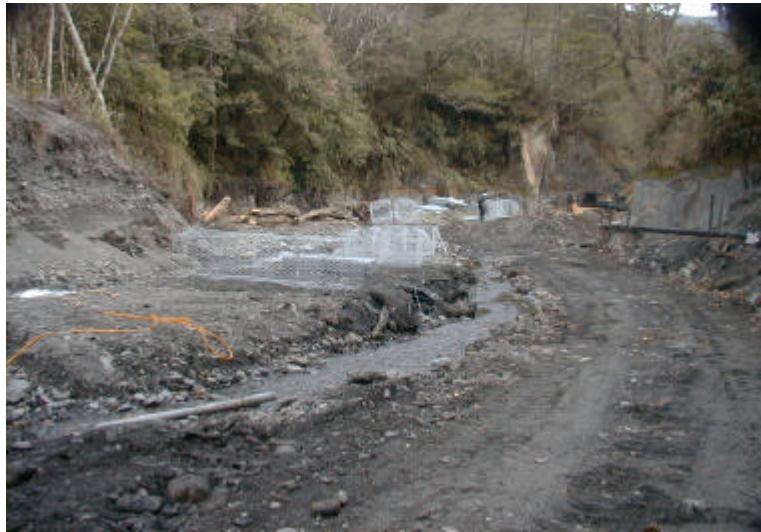
照片 5-14 斷面 2-7 施工狀況
