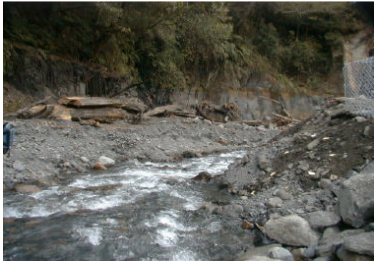
照片 5-15 斷面 2-4 左岸施工
