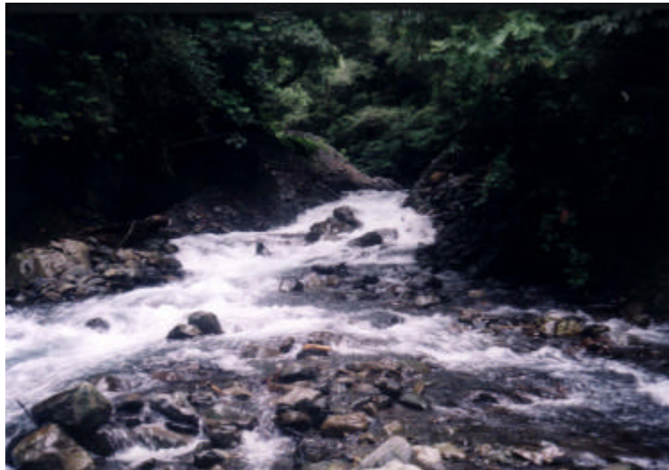
照片 2-2 三號壩改善後現場狀況
