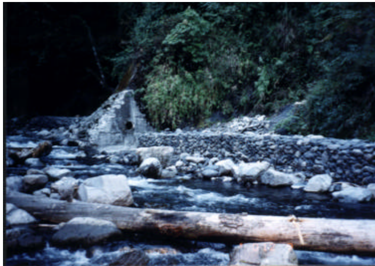
照片 2-4 四號壩下游兩岸蛇籠工
