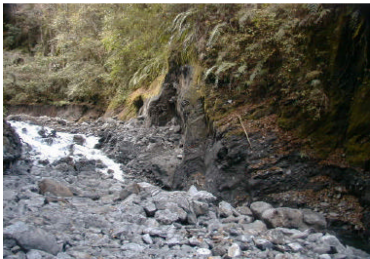
照片 5-9 三號壩第二次拆除後狀況
