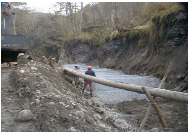
照片 5-16 斷面 2-2 右按蛇籠工保護施工照片
