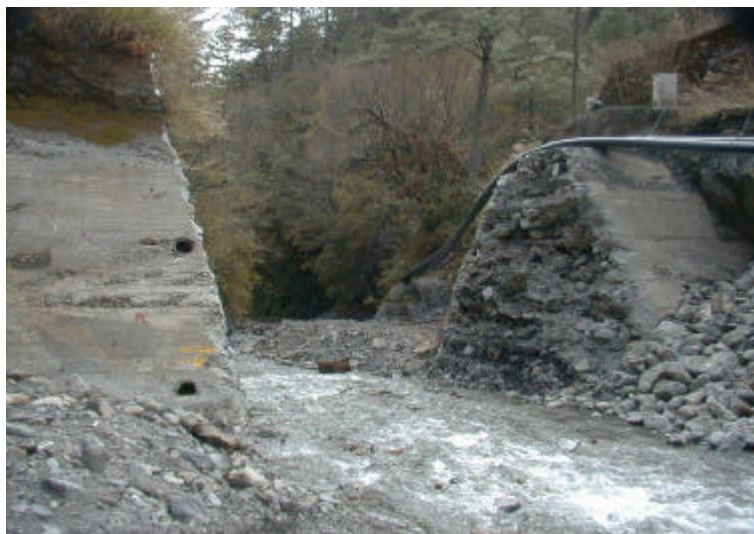
照片 5-23 斷面 1-1 壩口狀況
