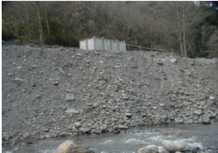
照片 5-22 斷面 1-2 右岸儲水箱
