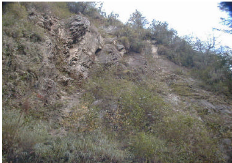
照片 5-3 斷面 3-21 左岸崩坍岩壁
