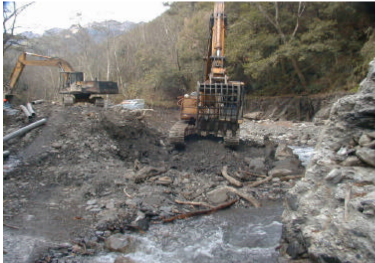
照片 5-17 斷面 2-1 二號壩口怪手施工狀況
