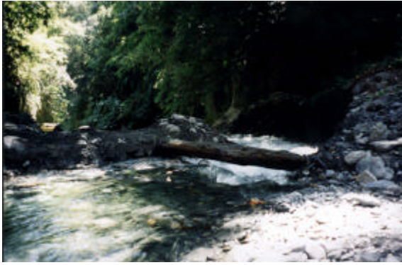
圖3-60 三號壩上游河床(10月拆除中)
