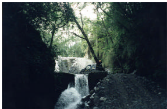
圖3-106 2號壩及其副壩(10月施工中道路)
