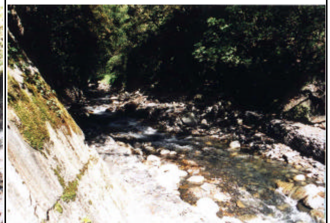
圖 1-10 四號壩開口上游兩側加設蛇 籠保護邊坡(89年11月)
