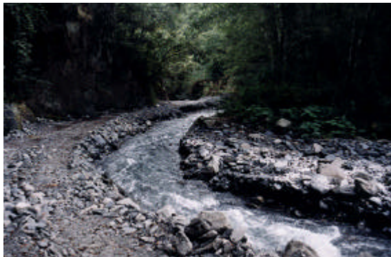
圖3-77 人工渠道Sec2-U斷面河床(10月拆壩中)
