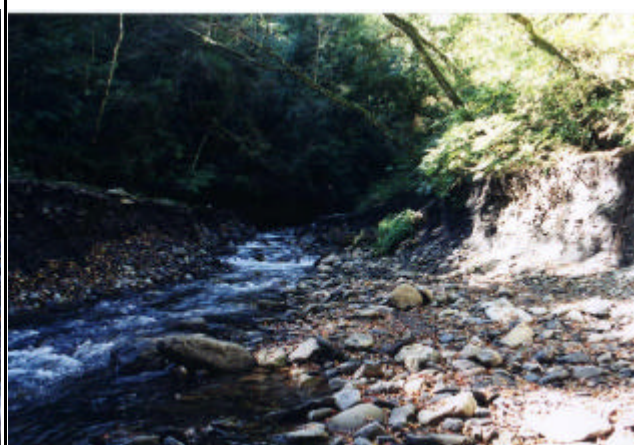
圖 1-9 三號壩完工後，上游河床形成 梯形深槽(89年11月)
