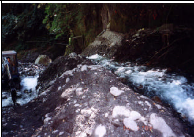
圖 1-6 三號壩施工，左右兩側分次開 鑿缺口(89年10月)
