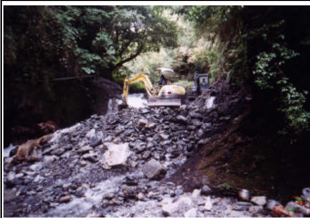
圖 1-5 三號壩以履帶機械施工 (89年10月)
