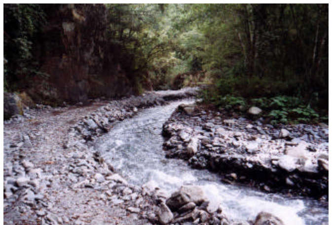
圖 1-4 施工便道改變原有棲地型態
