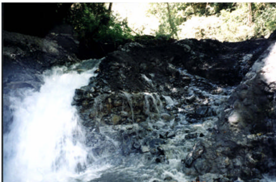
圖3-62 三號壩拆壩中下游斷面
