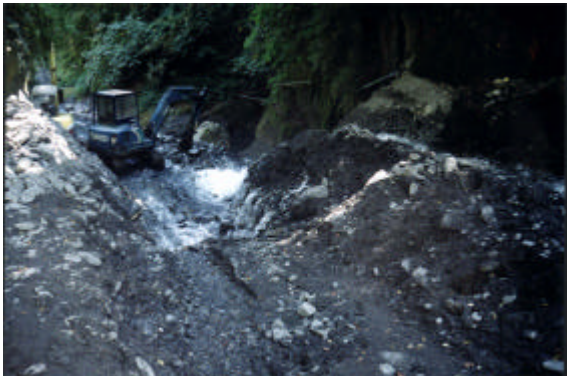
圖3-61 三號壩進行拆除工程(10月)
